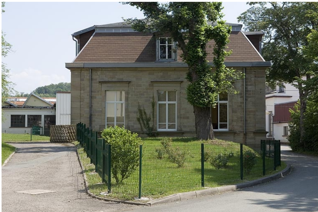
Ancien logement patronal, actuellement bureau.
