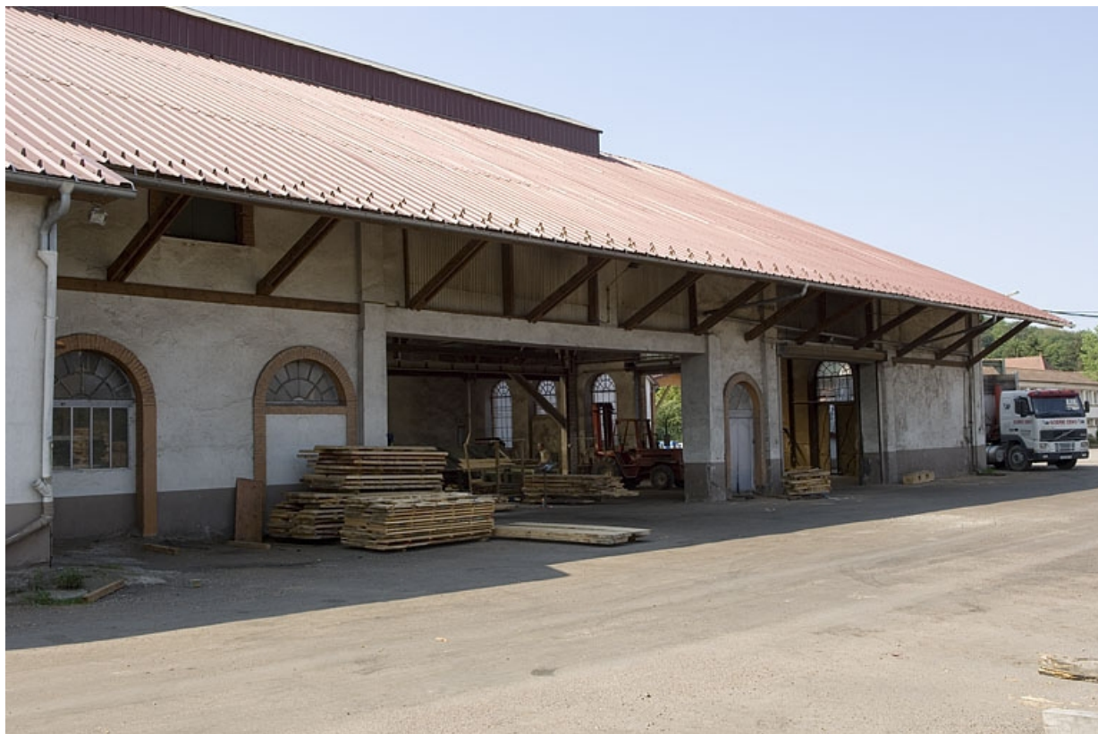
Façade nord de l'atelier de fabrication.
