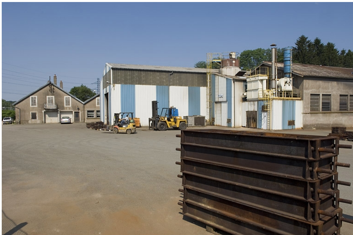
L'ancien et le nouvel atelier de fonderie.
