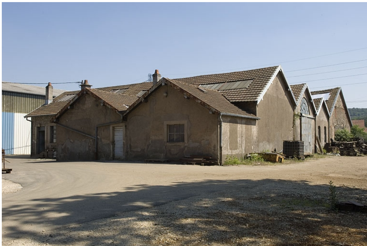
Atelier de fonderie primitif vu de trois quarts arrière. 70, Ronchamp, 14 rue des Mineurs
