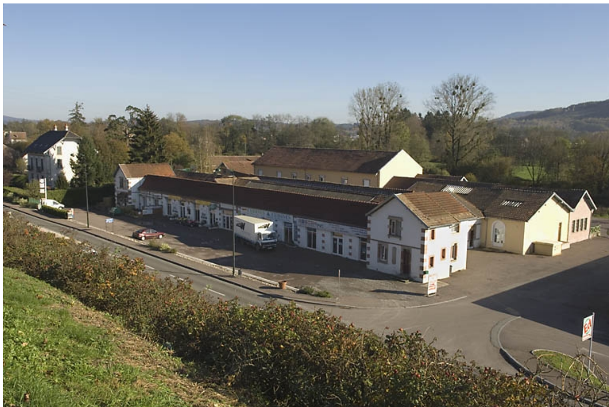
Vue plongeante depuis l'ouest.
