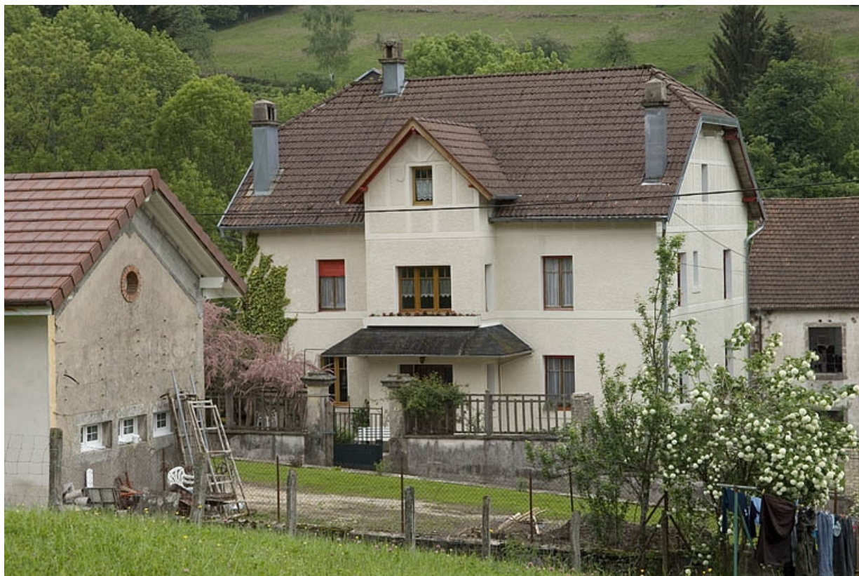
Logement du comptable (rue de la l'Usine aux Cités). 70, Haut-du-Them-Château-Lambert, 6 rue du Tissage
