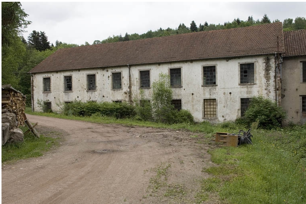
Façade nord-ouest de l'atelier de tissage.
