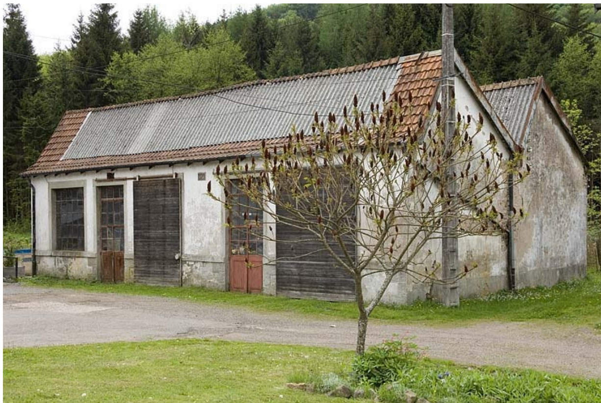
Atelier de réparation (menuiserie, forge).
