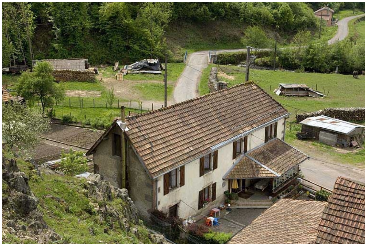
Vue plongeante sur un logement ouvrier.
