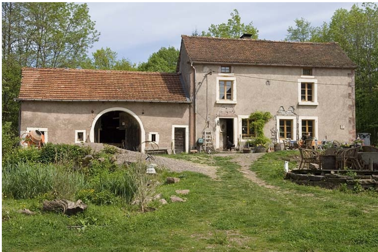
Façade antérieure des parties agricoles et du logement.
