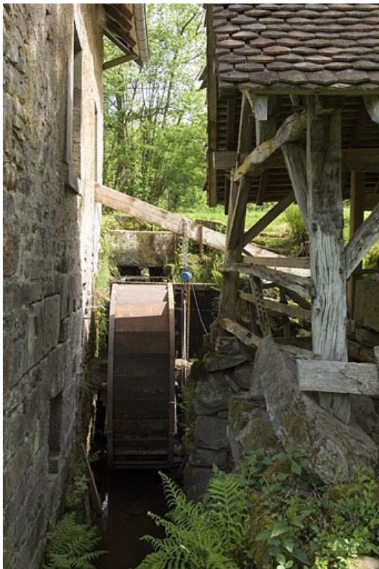
La roue hydraulique en dessus (en cours de réparation).
