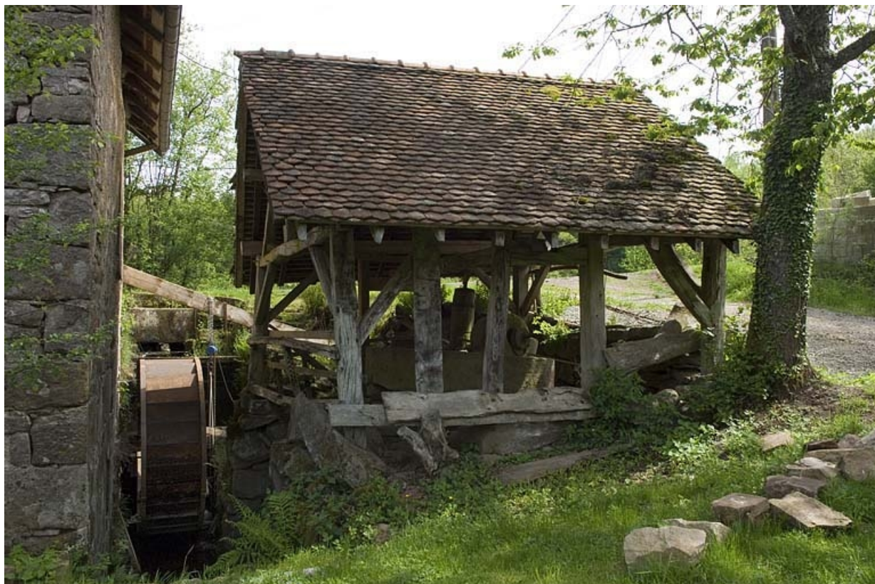
La roue hydraulique et la ribe vues depuis le sud.
