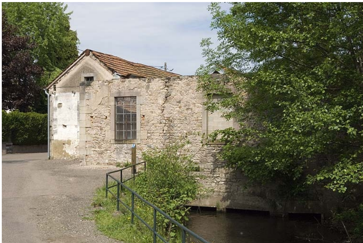
Pignons ouest de l'atelier de fabrication et canal de fuite.
