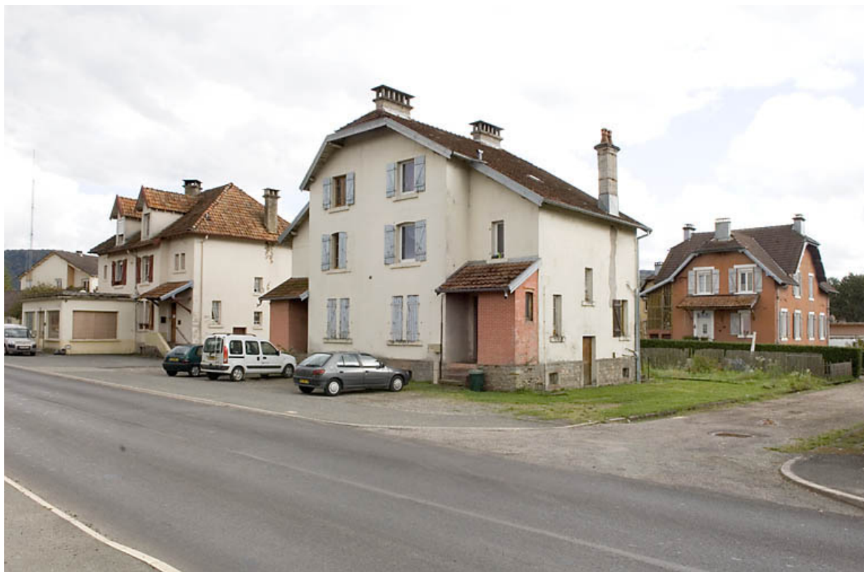
Vue d'ensemble de la cité ouvrière.
