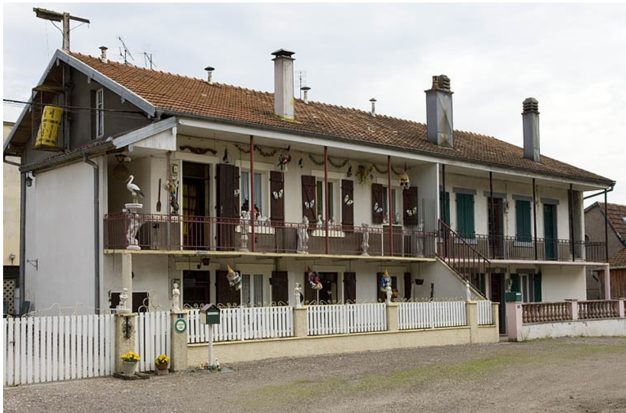
Logement ouvrier à étage (est). 70, Mélisey, 54 à 58 route de Lure
