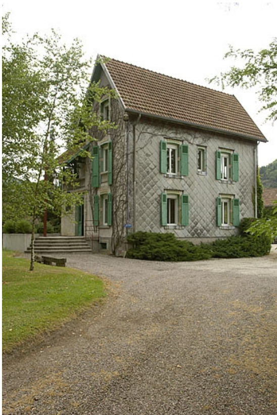
Ancien logement patronal. Vue depuis l'entrée.
