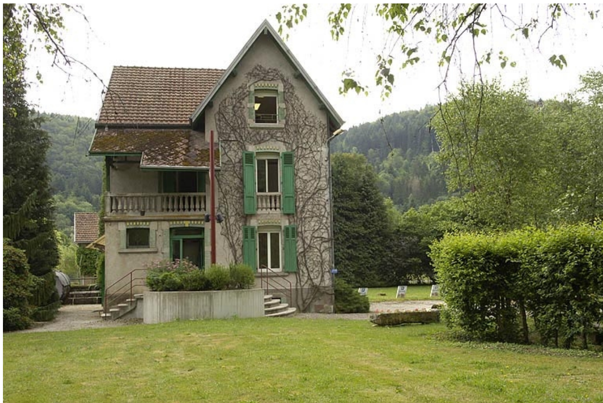
Ancien logement patronal. Façade ouest.
