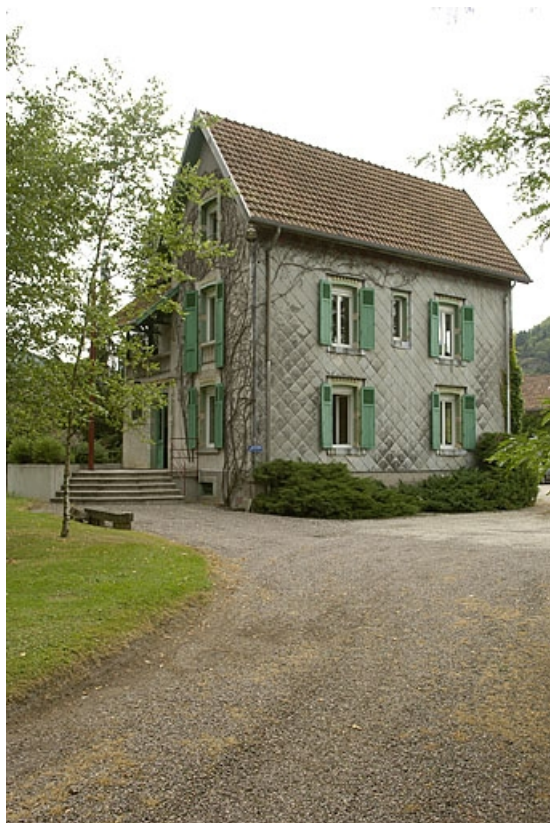
Ancien logement patronal. Vue depuis l'entrée.
