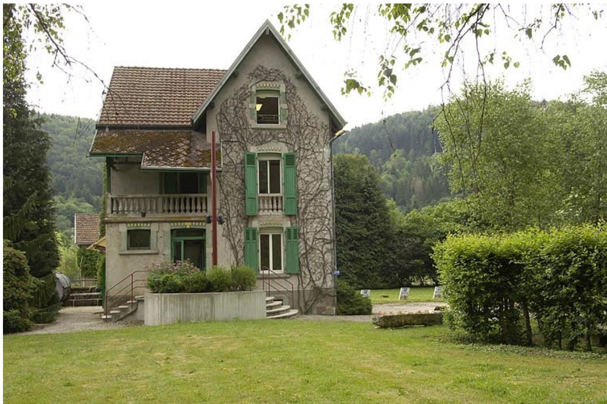
Ancien logement patronal. Façade ouest.
