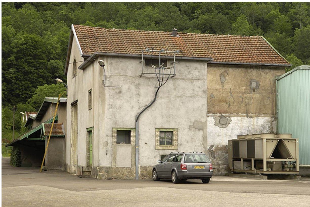
Transformateur et ancienne chaufferie.
