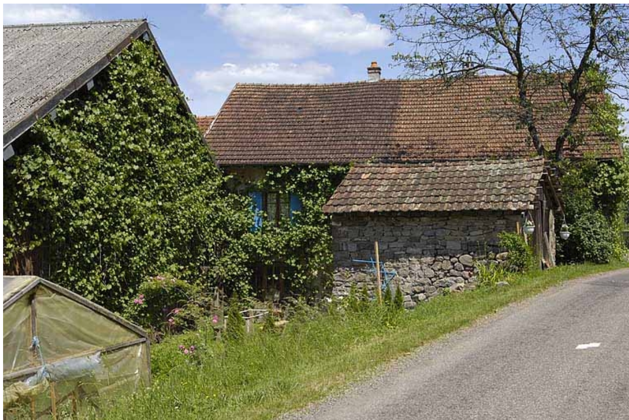
Façade postérieure du logement.
