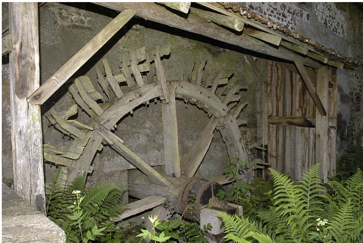
Détail de la roue hydraulique en dessous.
