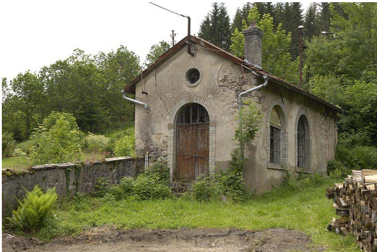
Ancienne centrale hydroélectrique.
