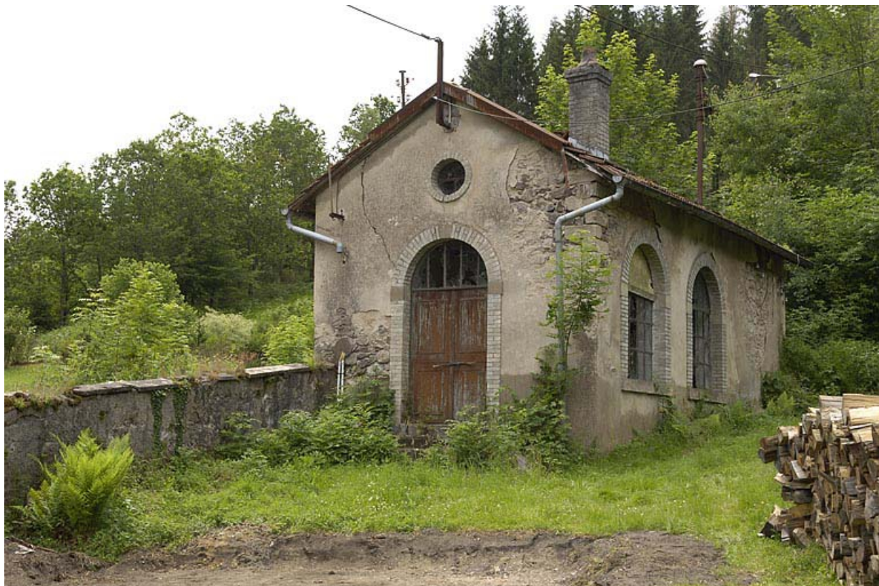
Ancienne centrale hydroélectrique.
