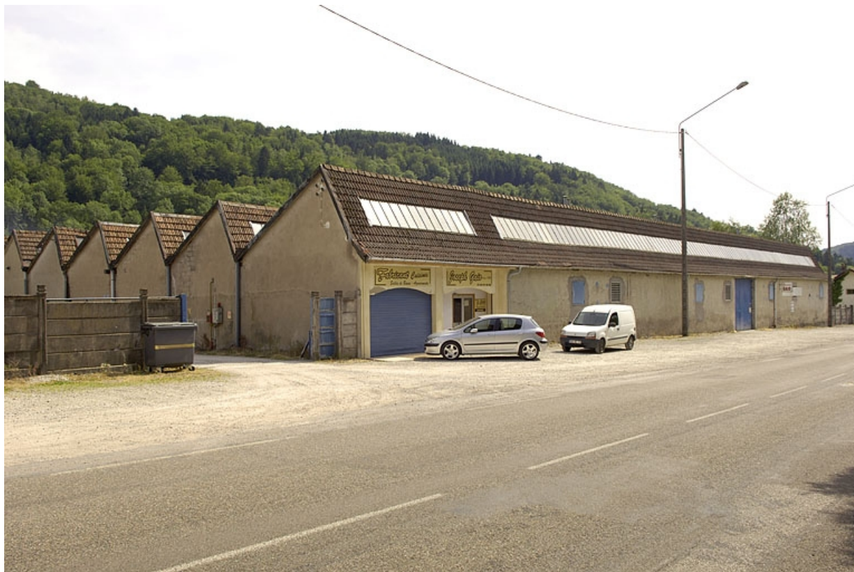
Atelier de fabrication (tissage) depuis le nord. 70, La Longine, 5 à 9 avenue Carlos Dorget
