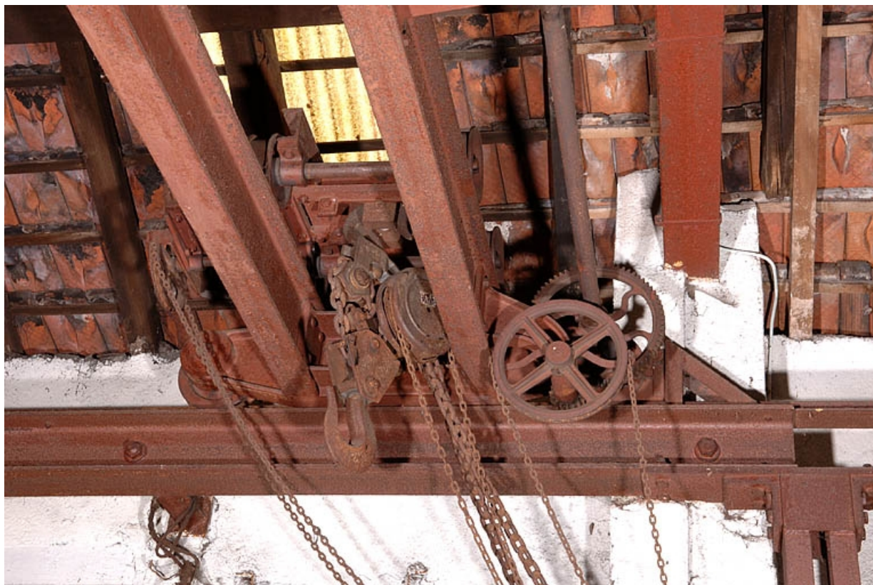
Atelier dit des Balanciers. Le palan du pont roulant.
