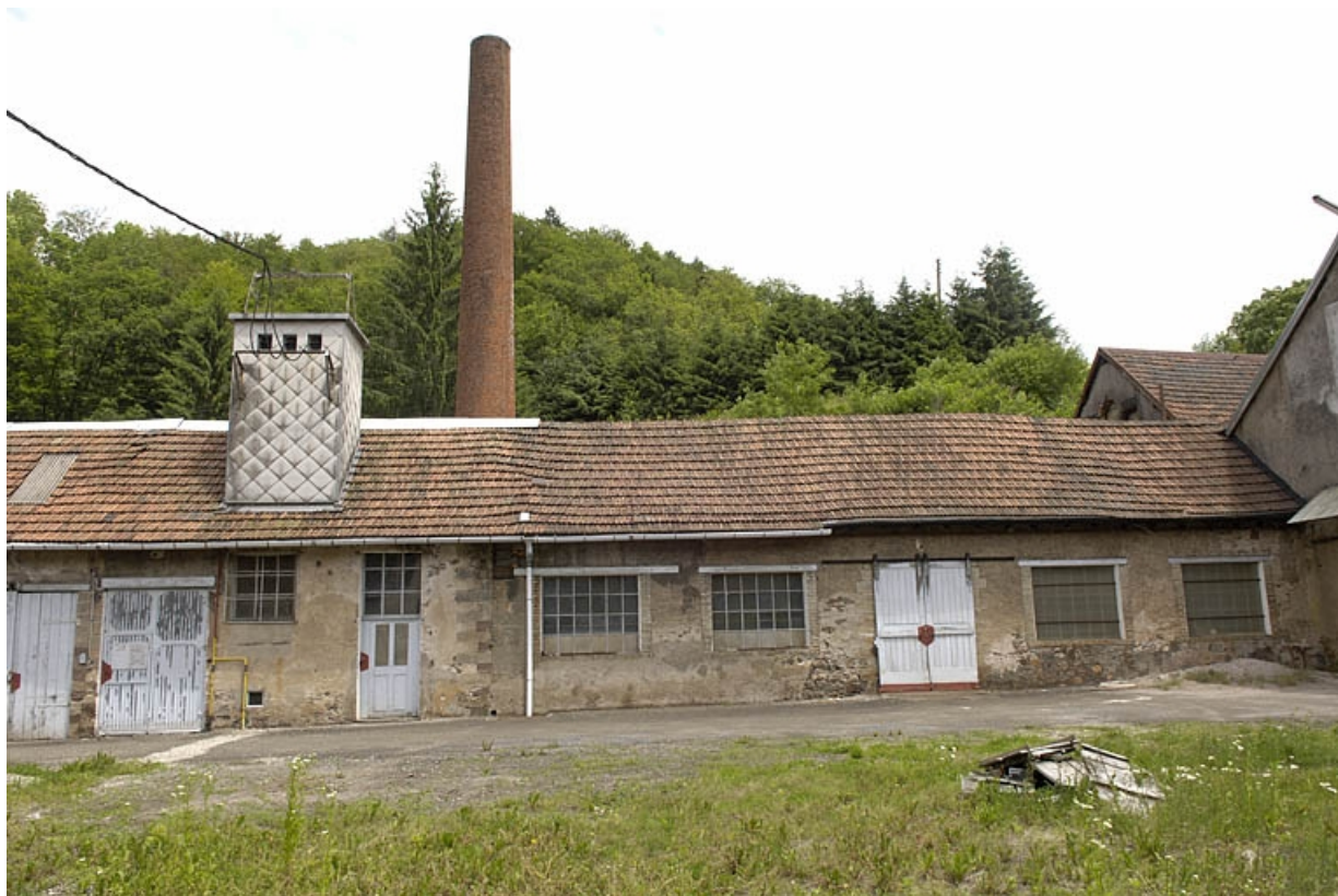
Façade sud-ouest de l'atelier de polissage.
