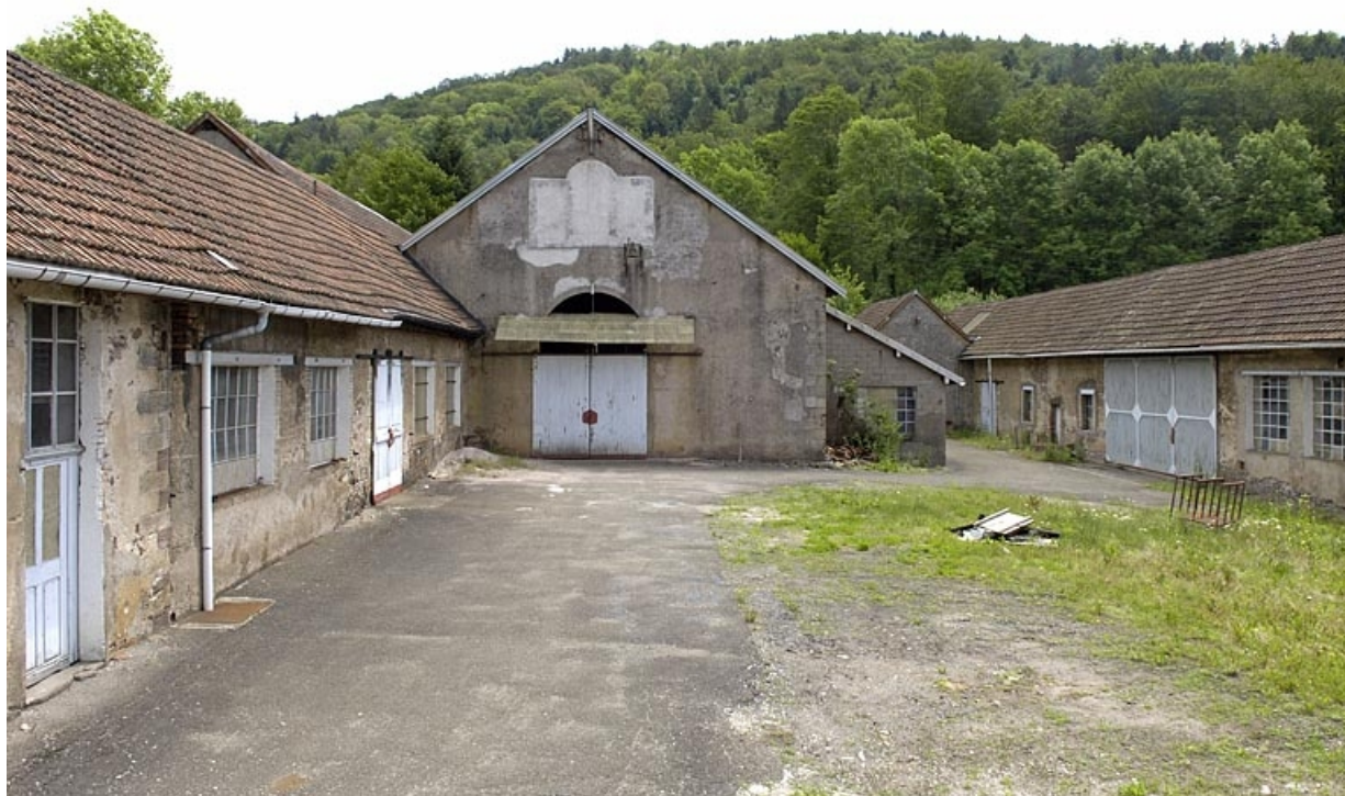
Atelier de polissage et forge du Bas depuis le nord-ouest.
