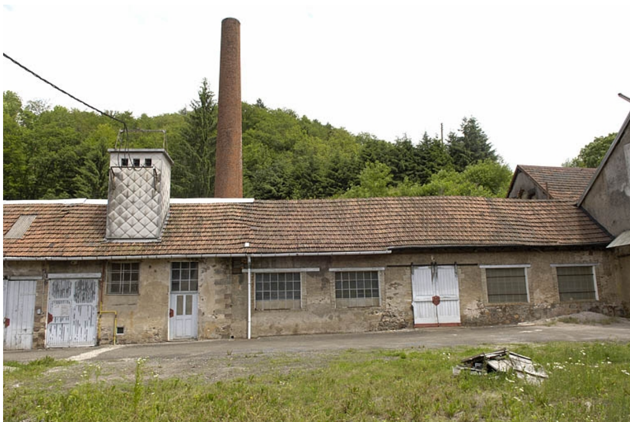
Façade sud-ouest de l'atelier de polissage.
