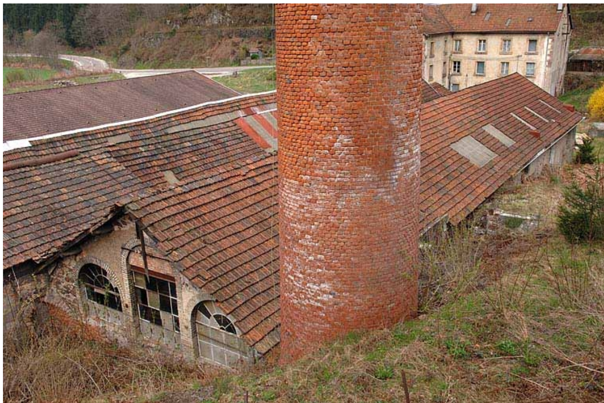
Vue sur les toitures des ateliers de fabrication.
