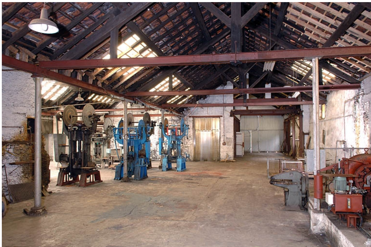
Travée nord-est de l'atelier dit des Balanciers.
