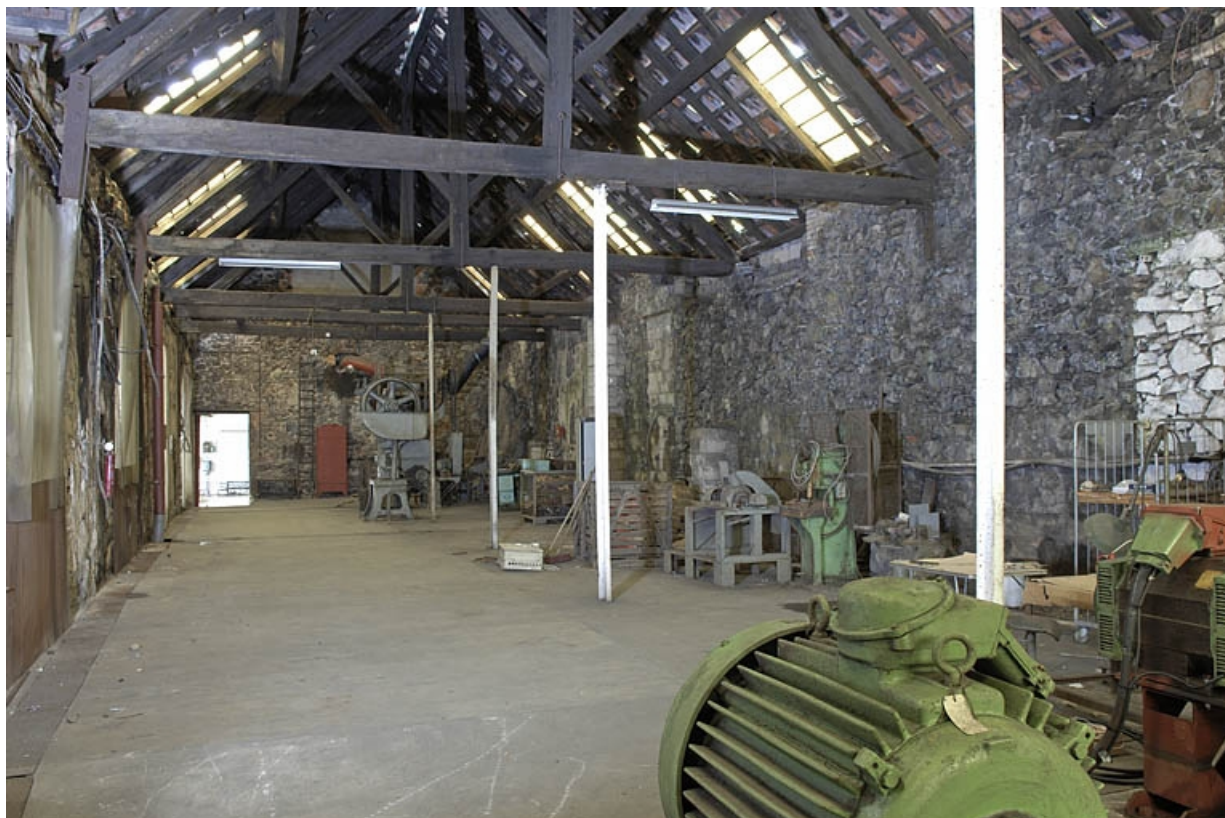
Vue d'ensemble de la forge du Haut depuis le sud.
