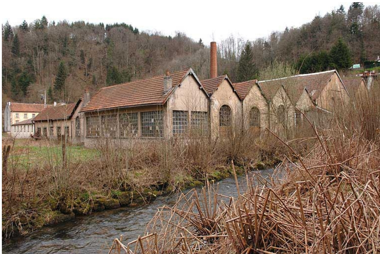
Vue des ateliers depuis le sud.
