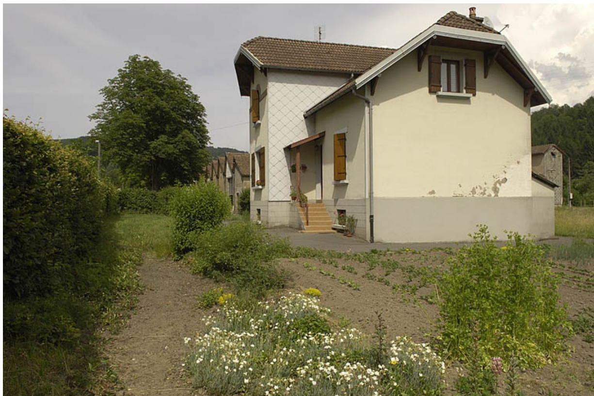
Logement de contremaître. Vue de trois quarts. 70, Corravillers R.D. 6
