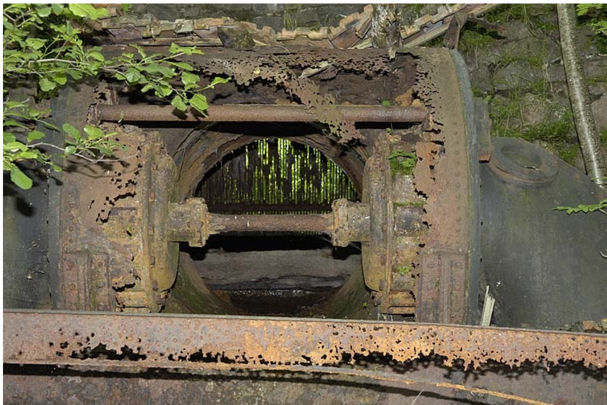
Turbine hydraulique à axe horizontal. Détail (les aubes ont disparu). 70, Corravillers R.D. 6
