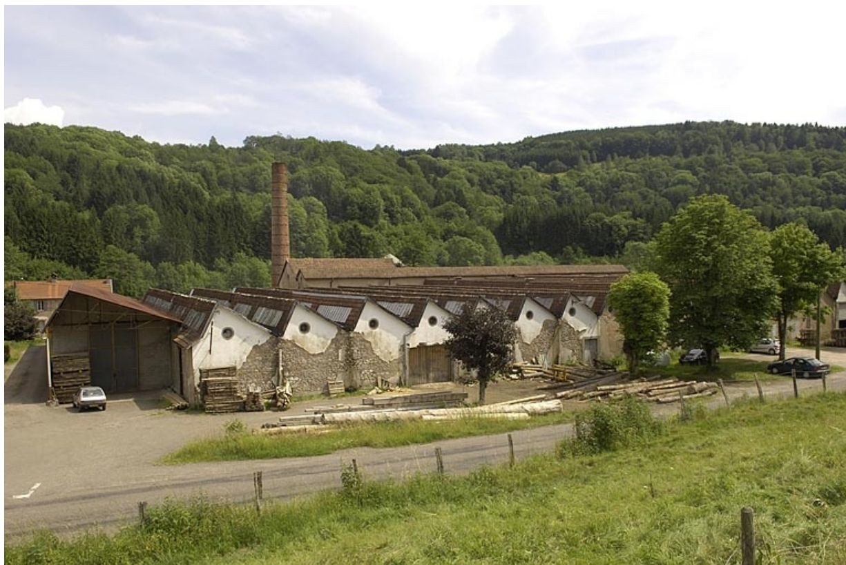
Vue plongeante sur les ateliers de fabrication.
