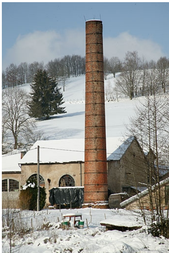
Salle des machines et sa cheminée.
