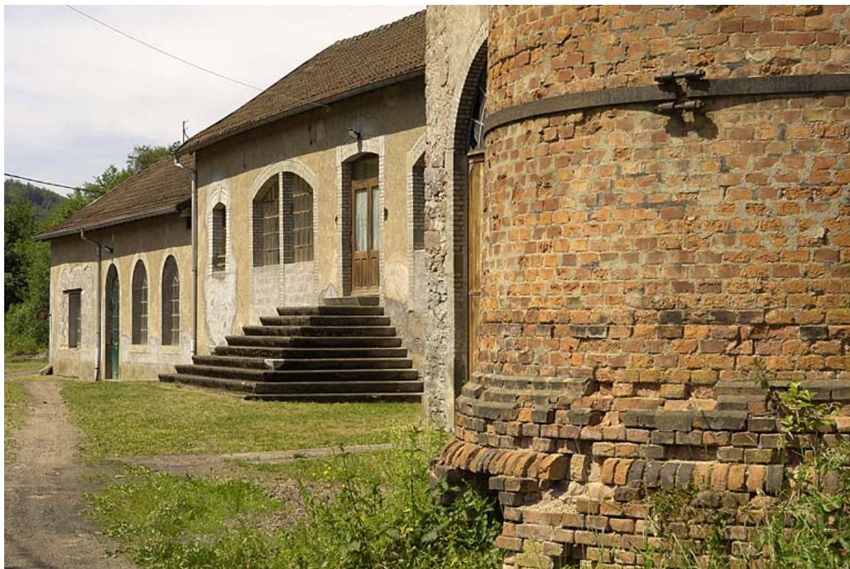
Façade postérieure et détail de la base de la cheminée.
