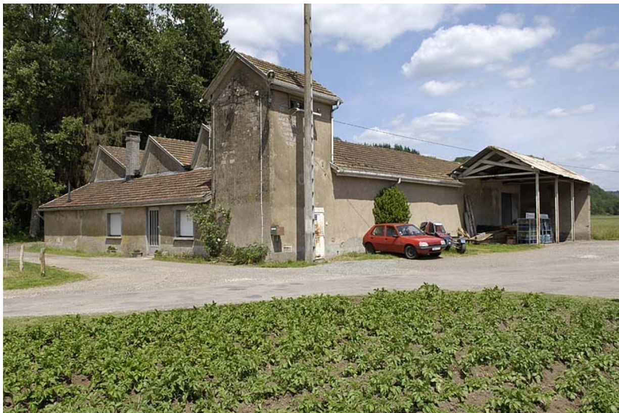
Vue d'ensemble depuis l'ouest.
