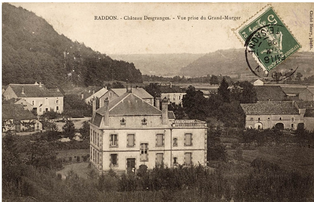
Raddon - Château Desgranges. - Vue prise du Grand-Murger.
