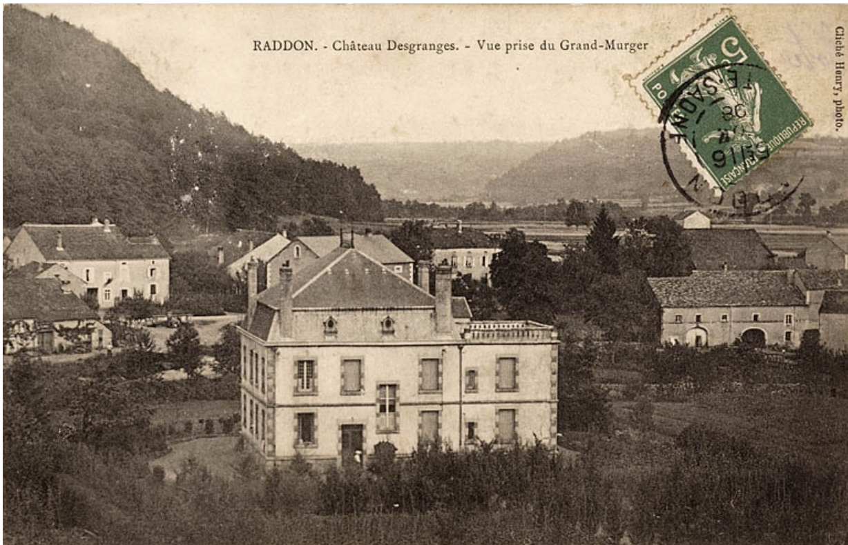
Raddon - Château Desgranges. - Vue prise du Grand-Murger.
