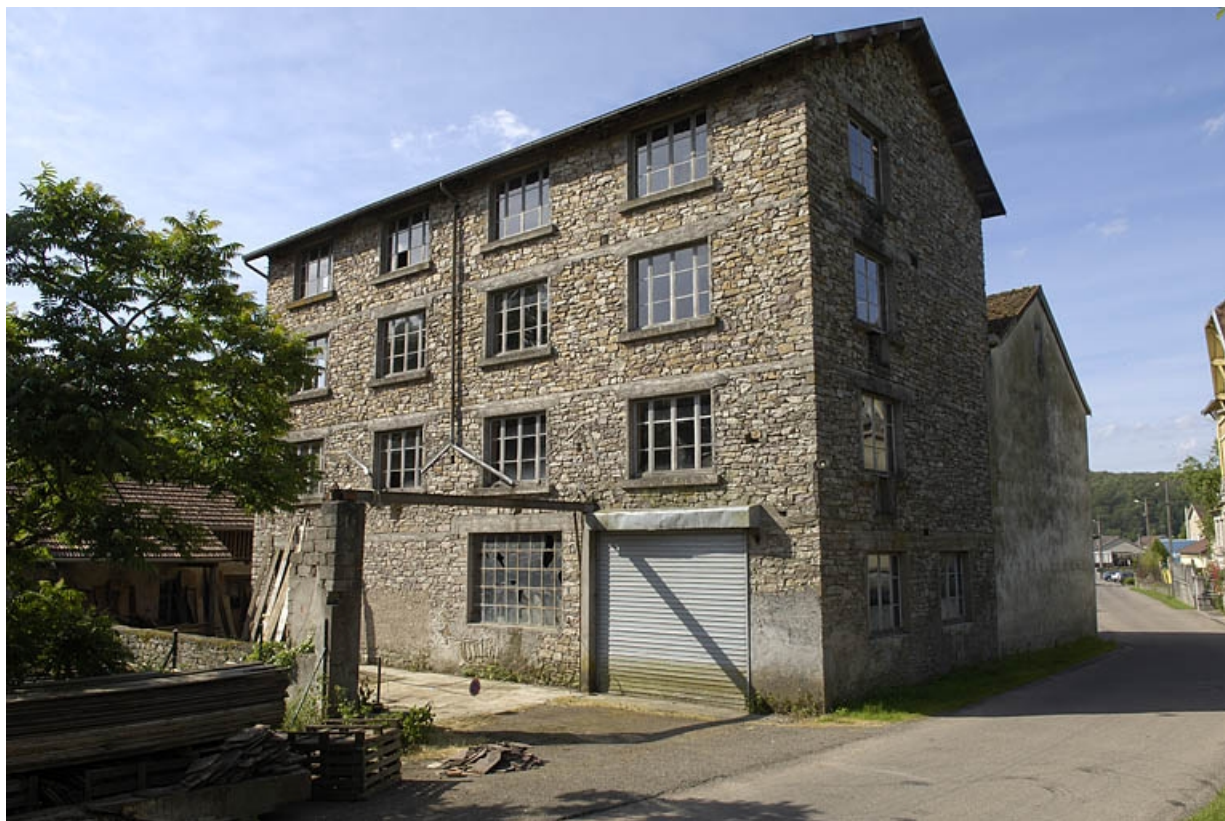
Extension orientale de l'atelier de fabrication.
