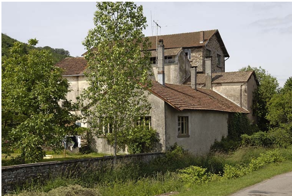
Vue depuis l'aval, sur la rive gauche du Raddon.
