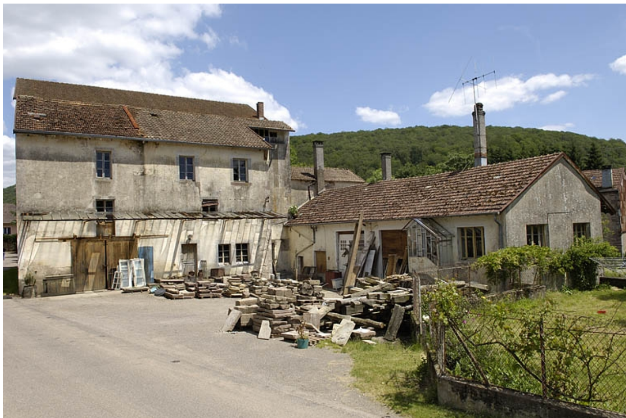
Le moulin et le bâtiment abritant le bureau, un logement et le garage.
