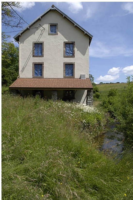
Façade nord-ouest et appentis abritant la turbine.
