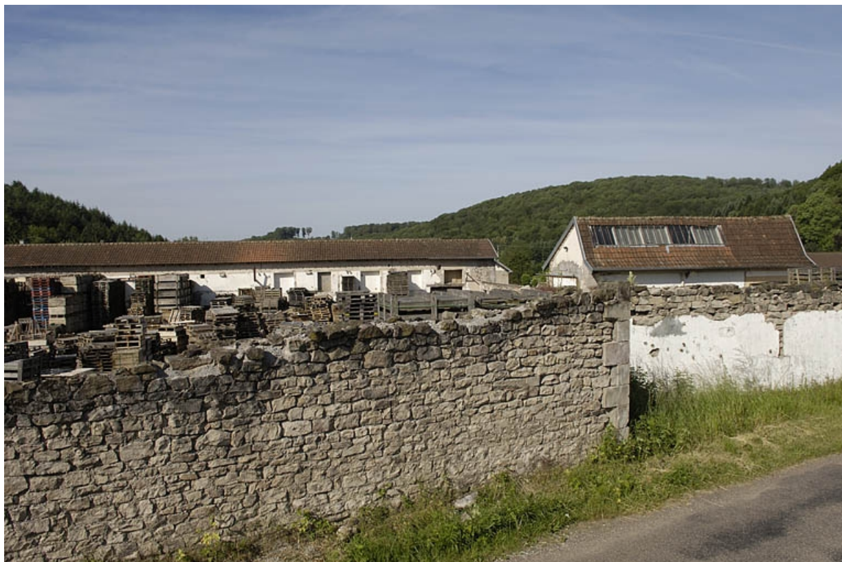
Vue des ateliers de filature depuis le nord. 70, Saint-Bresson, lieudit : les Maires d'Avaux
