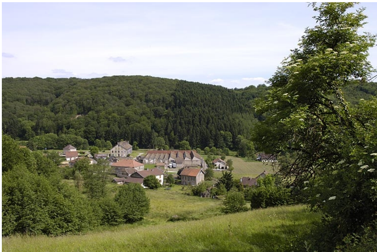
Vue générale plongeante depuis le nord-ouest.
