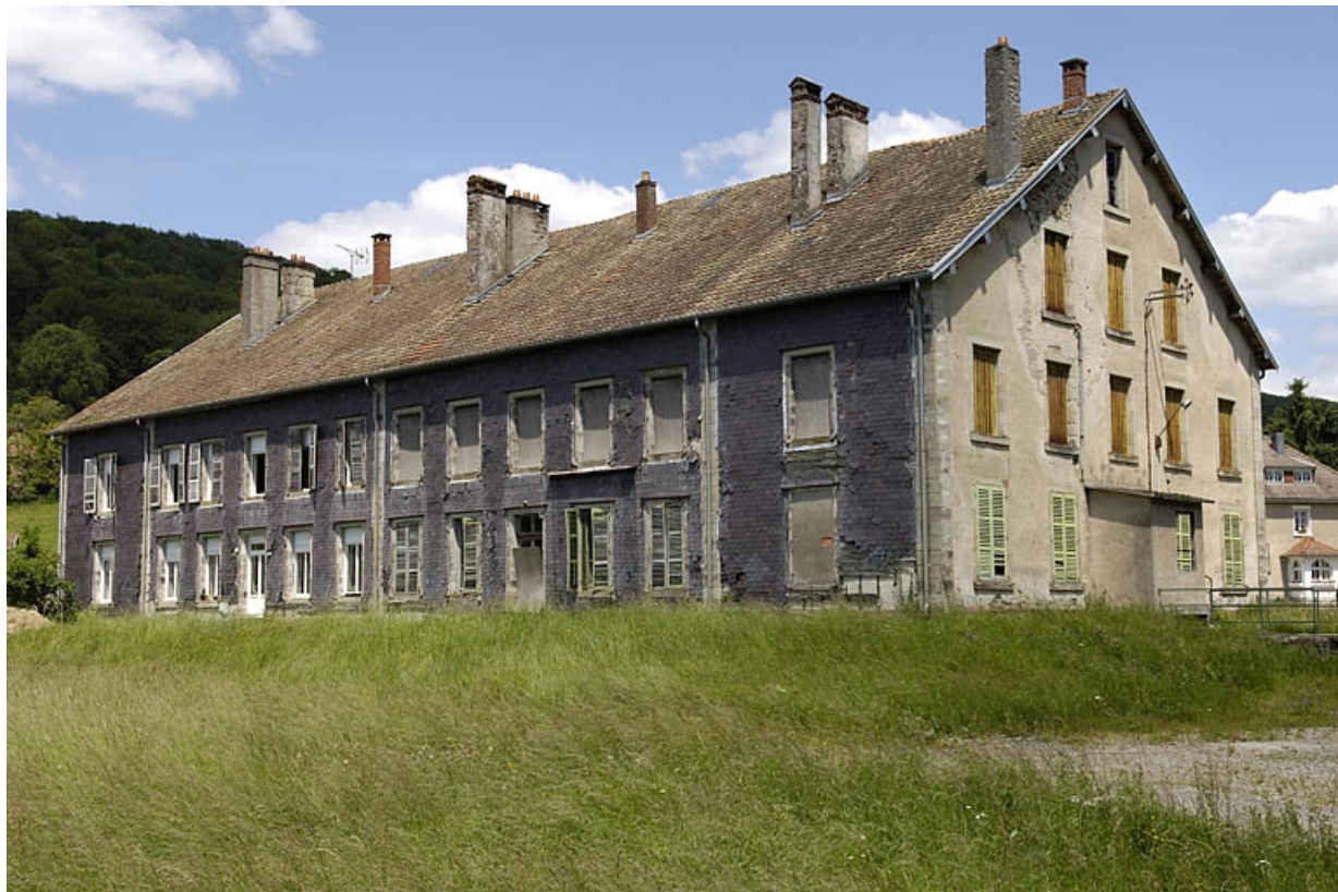
Façade ouest de l'ancien logement patronal, devenu logement ouvrier.
