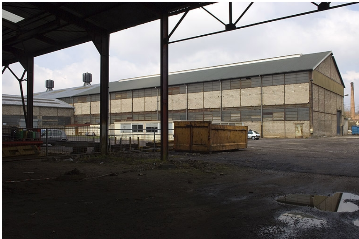
Vue d'ensemble de l'atelier de fabrication depuis l'est.
