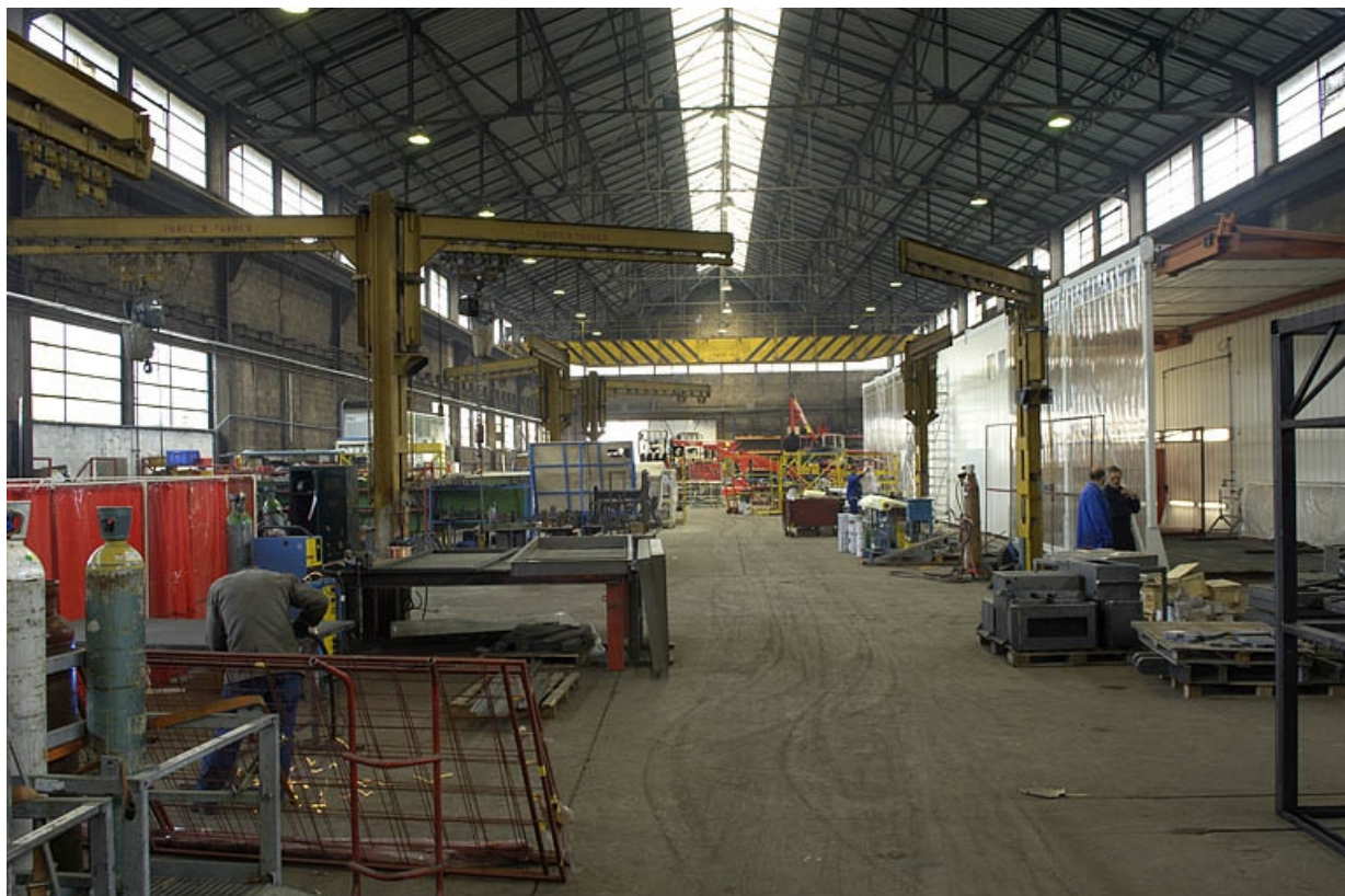
Atelier de fabrication. Vue intérieure depuis le sud.
