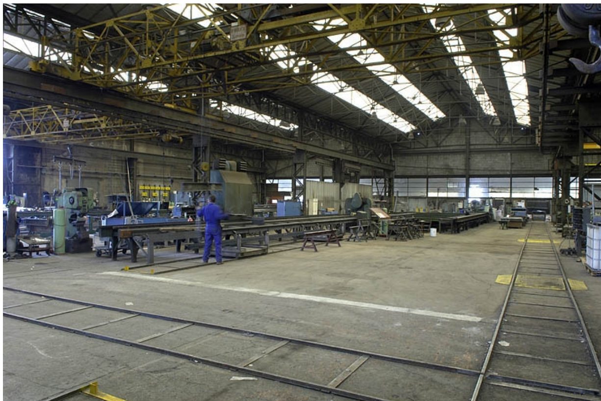
Atelier de fabrication secondaire. Vue intérieure depuis l'ouest.
