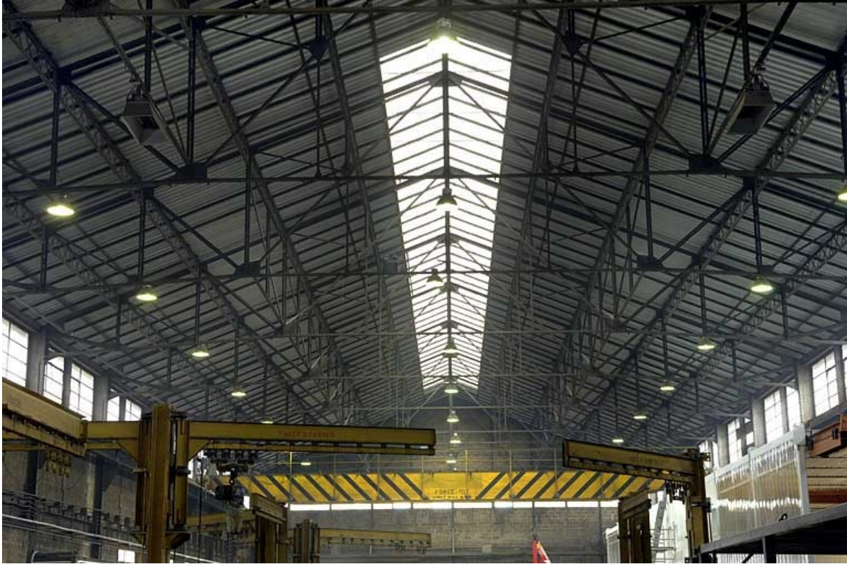
Atelier de fabrication. Charpente et couverture métallique.
