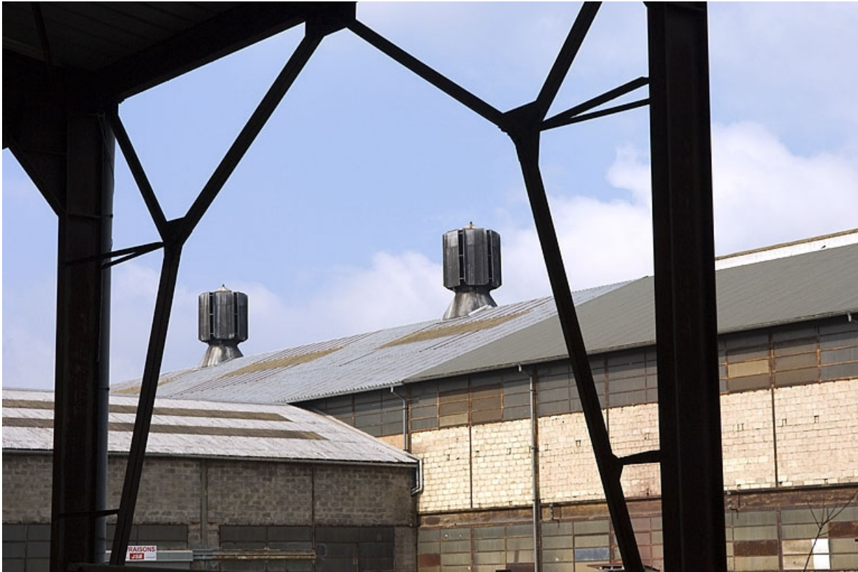
Atelier de fabrication. Cheminées d'extraction.
