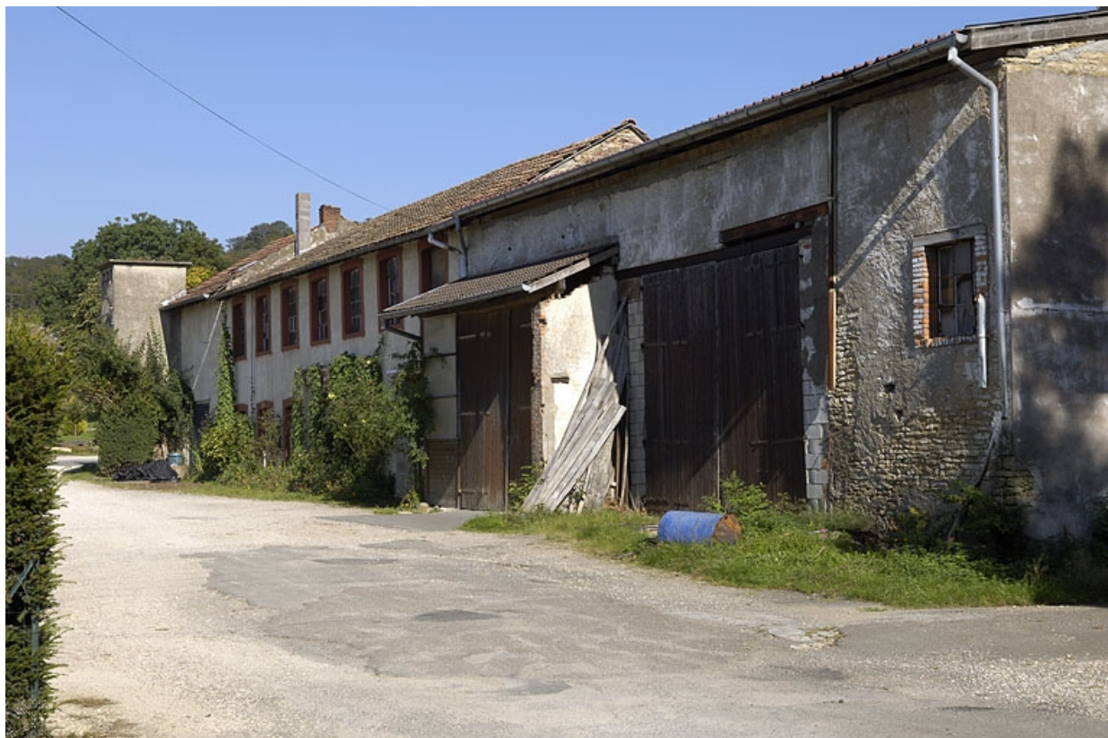
Atelier de boissellerie vu depuis la rue.
