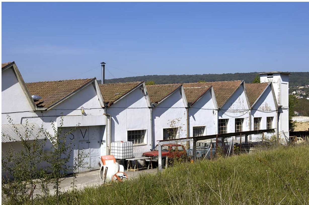
Murs pignons est de l'atelier de fabrication.
