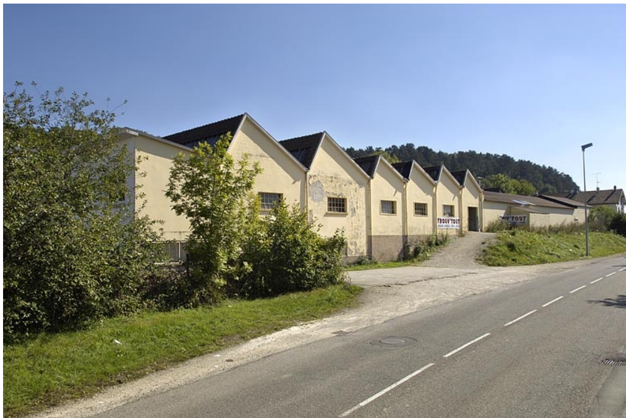
Façade sur rue de l'atelier de fabrication.
