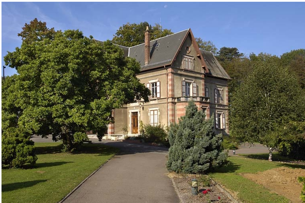
Vue de trois quarts depuis l'allée d'entrée.
