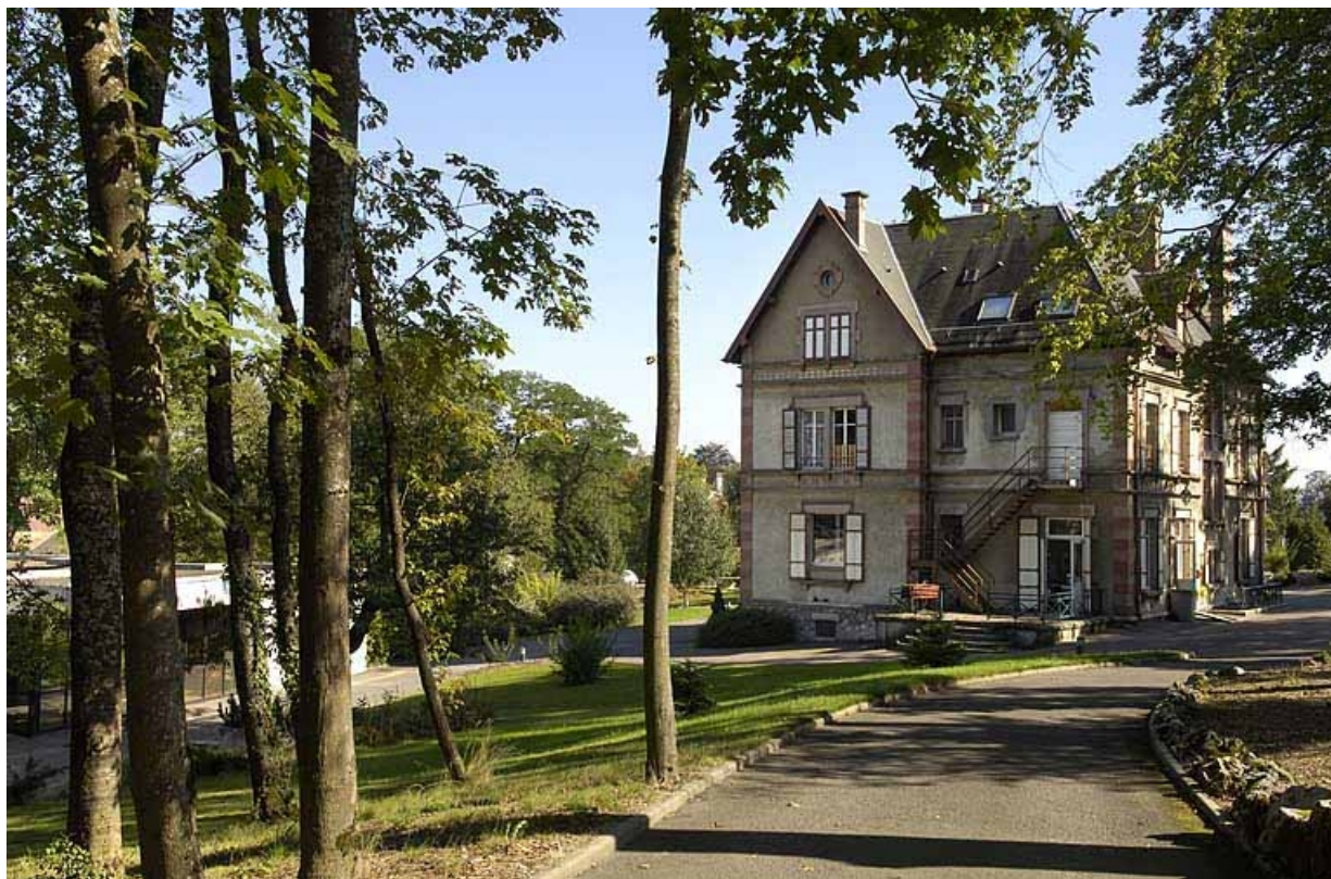
Vue d'ensemble depuis le sud.
