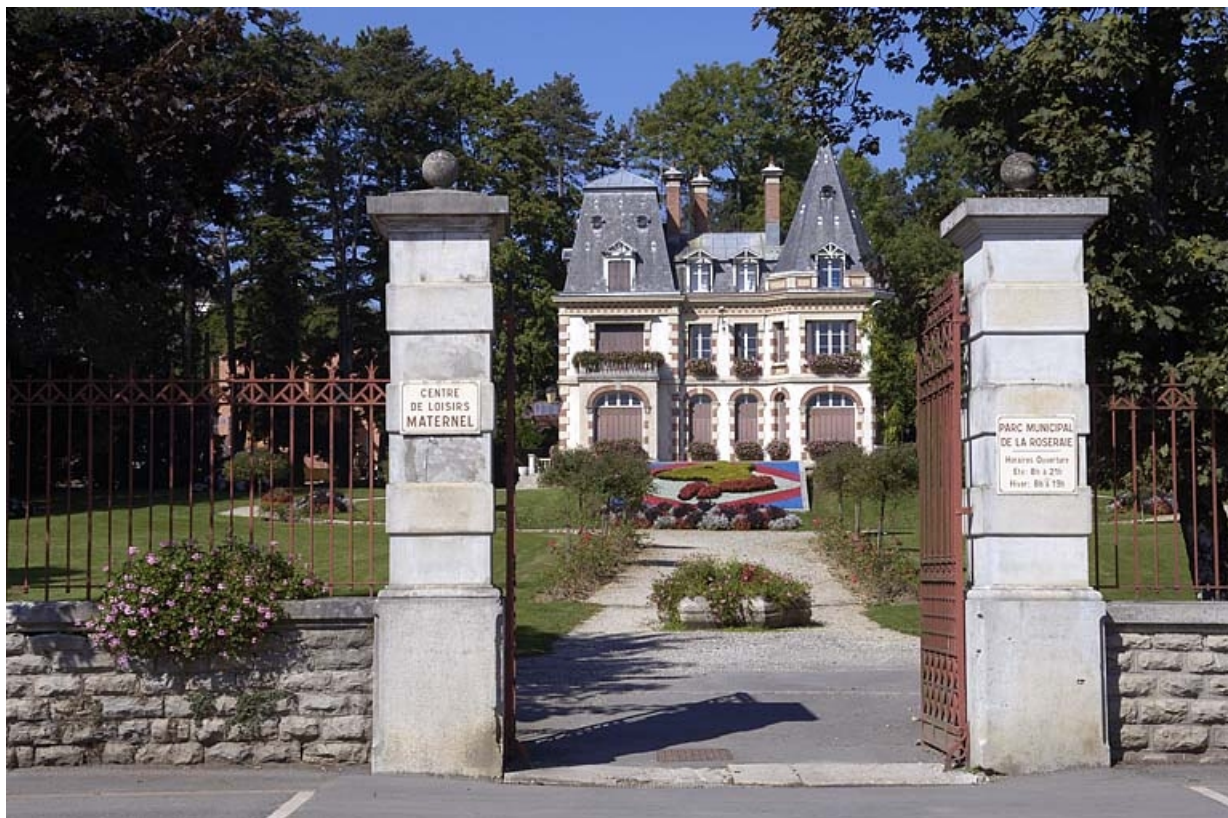
Vue d'ensemble depuis l'entrée du parc.
