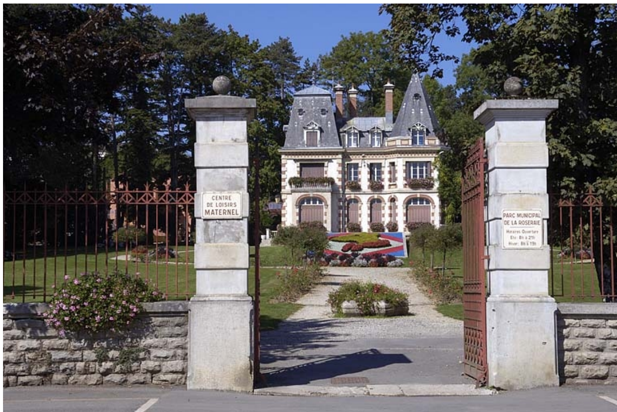
Vue d'ensemble depuis l'entrée du parc.
