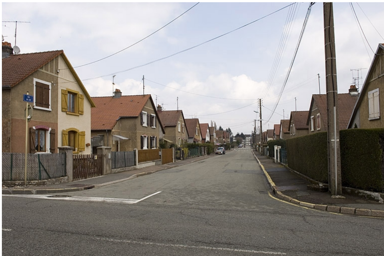
Vue d'ensemble de la rue Bel Air.
