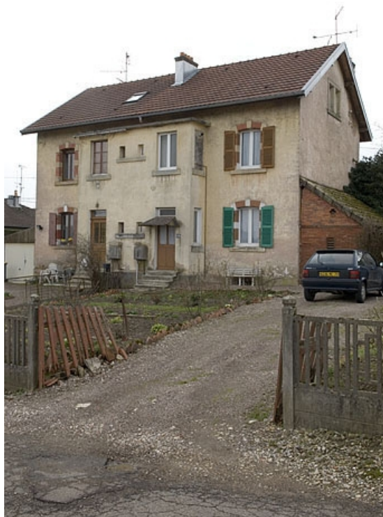
Maison ouvrière à quatre logements (côté rue de Colmar).
