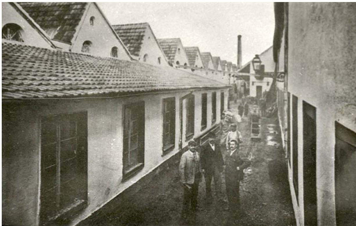
Ateliers de fabrication en rez-de-chaussée.
