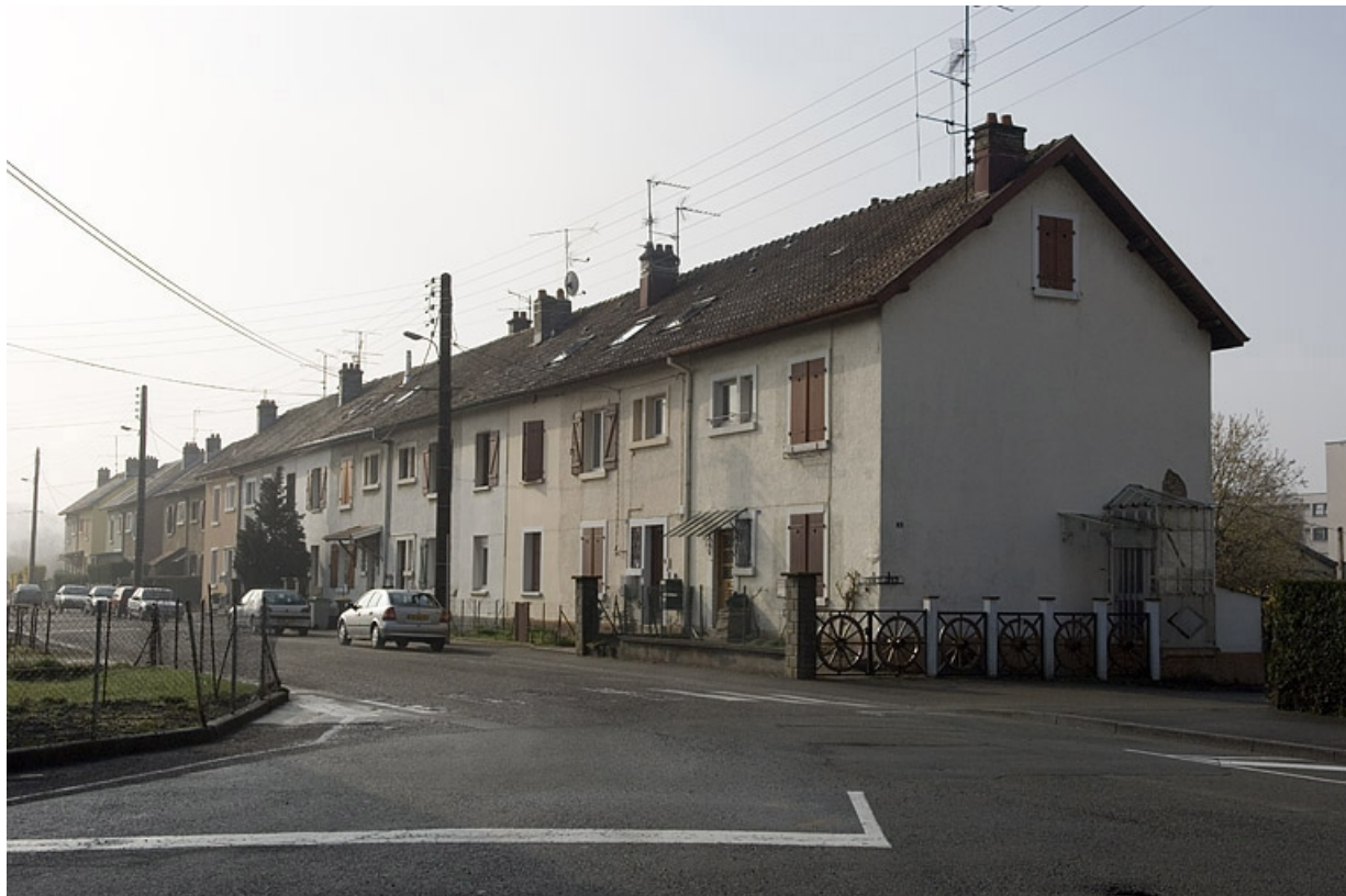
Logements ouvriers rue Paul Vinot. 70, Héricourt, 5, 7 rue du 11 novembre
