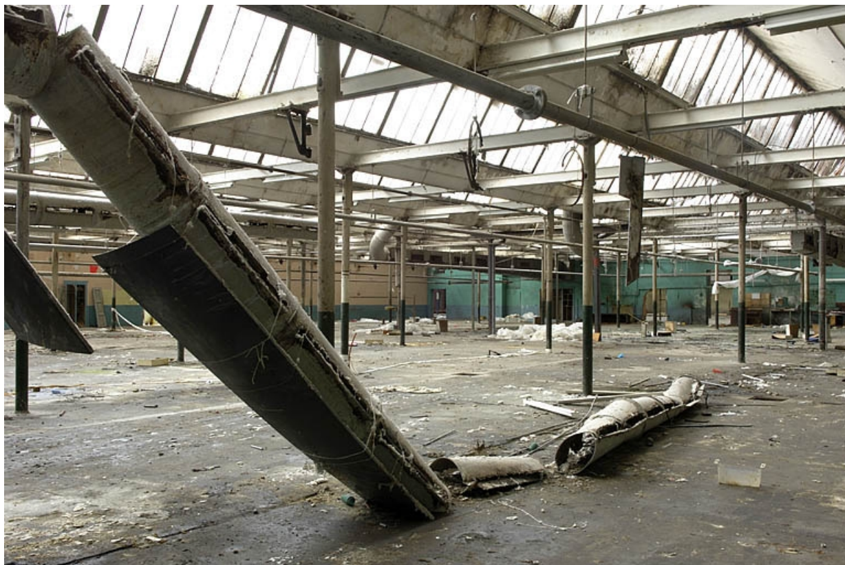
Extension est de la salle de tissage. Charpente métallique et sheds. 70, Héricourt, 5, 7 rue du 11 novembre
