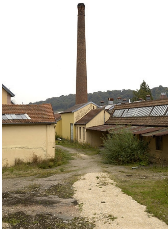
Atelier et cheminée depuis l'entrée.
