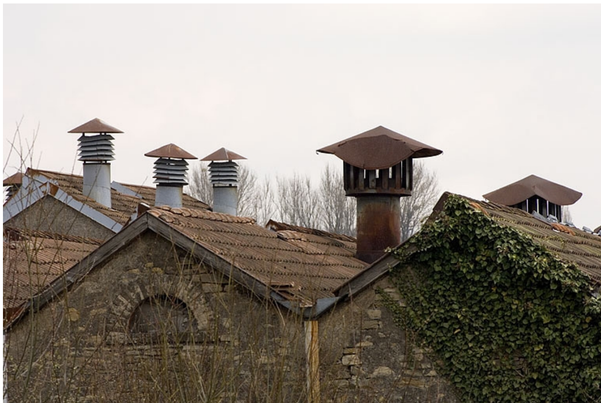
Cheminées métalliques de la salle de tissage.
