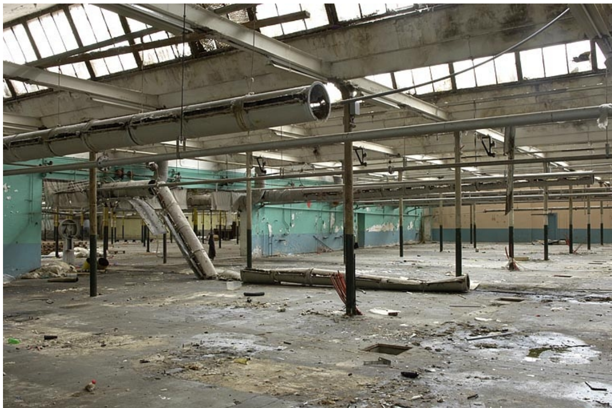
Extension est de la salle de tissage. Vue depuis le sud.
