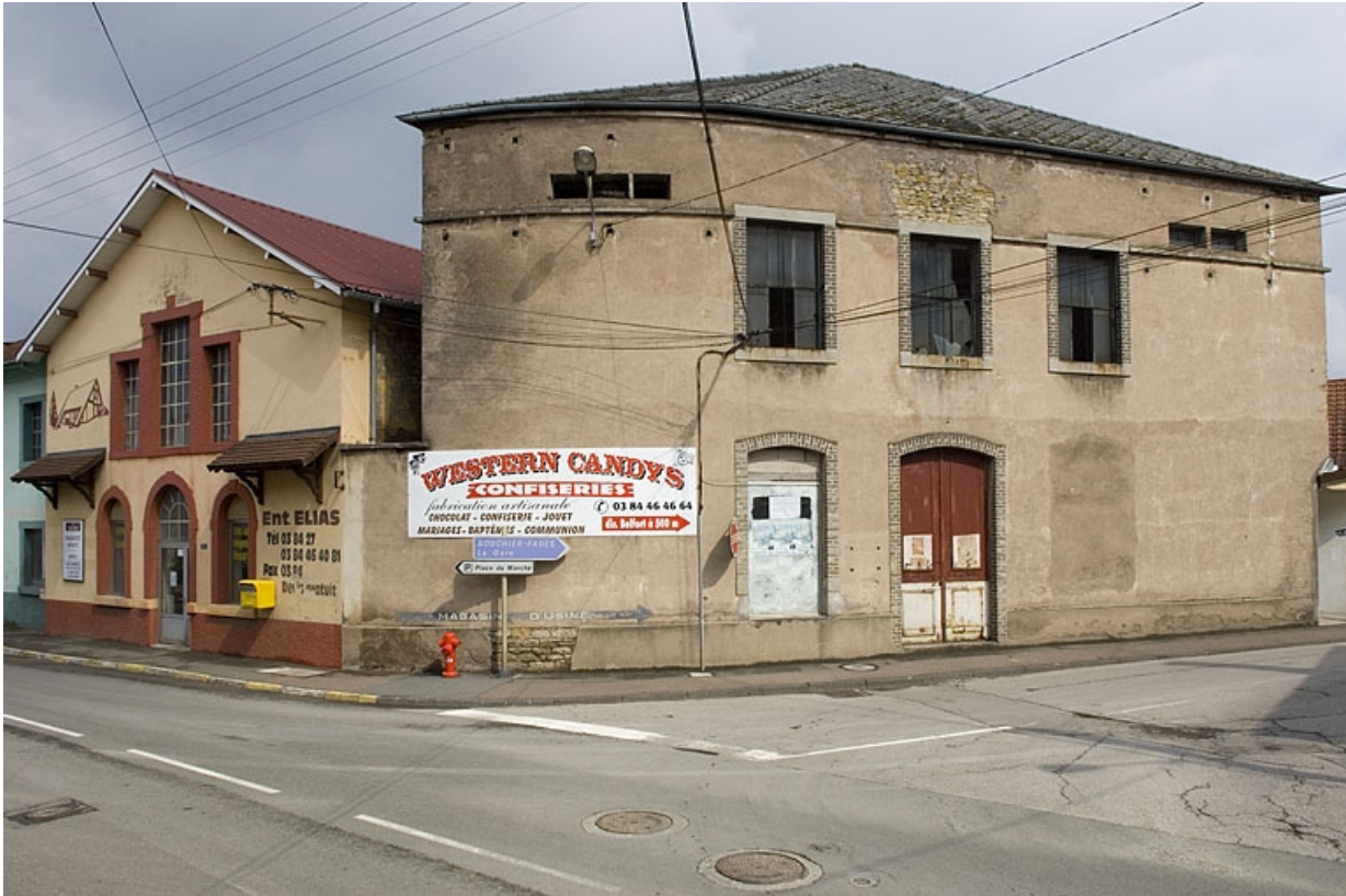
Bâtiments situés à l'intersection de l'avenue Jean Jaurès et de la rue Pasteur. 70, Héricourt rue Marcel Bardot
