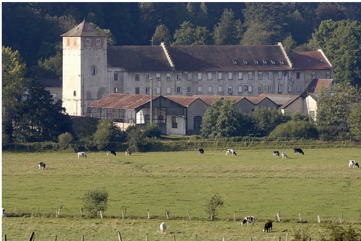
Atelier de fabrication à étages de la filature depuis le nord-est.
