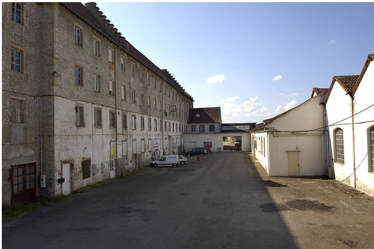
La cour entre l'atelier de fabrication à étages et l'atelier de bobinage. 70, Couthenans, lieudit : Chevret
