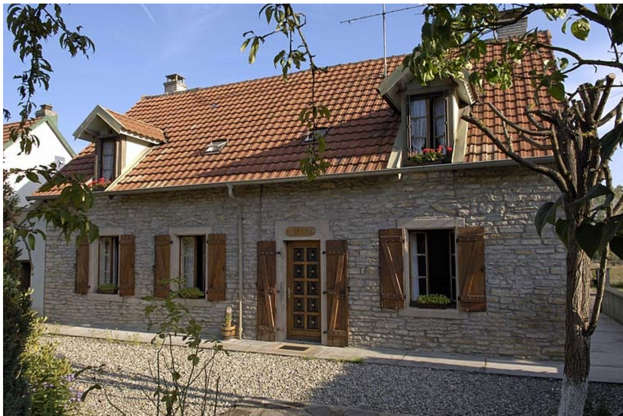
Façade postérieure d'un logement ouvrier.
