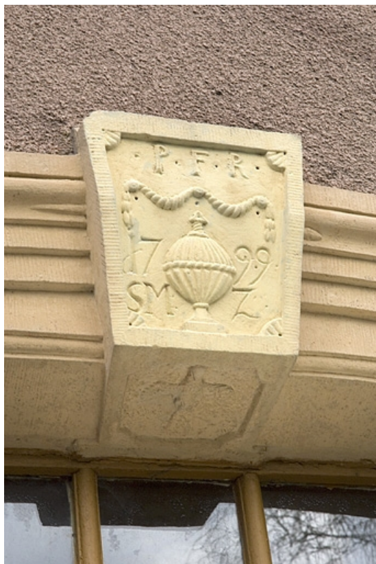
Linteau de la porte du logement. Détail de l'élément central ornementé. 70, Couthenans, lieudit : au Moulin
