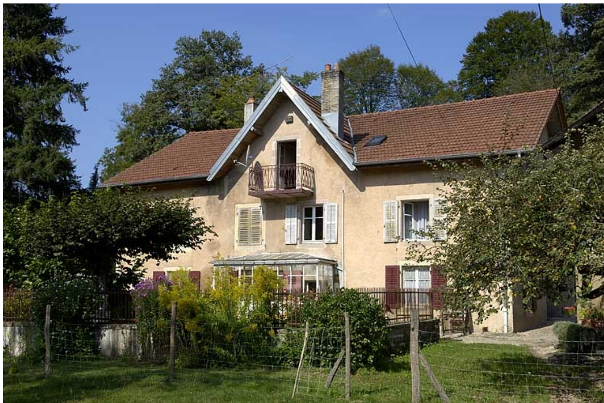
Façade sud du moulin.
