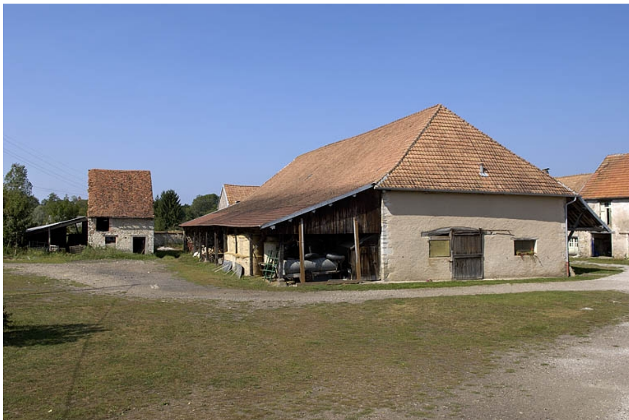
Vue depuis le sud-ouest de la cour.
