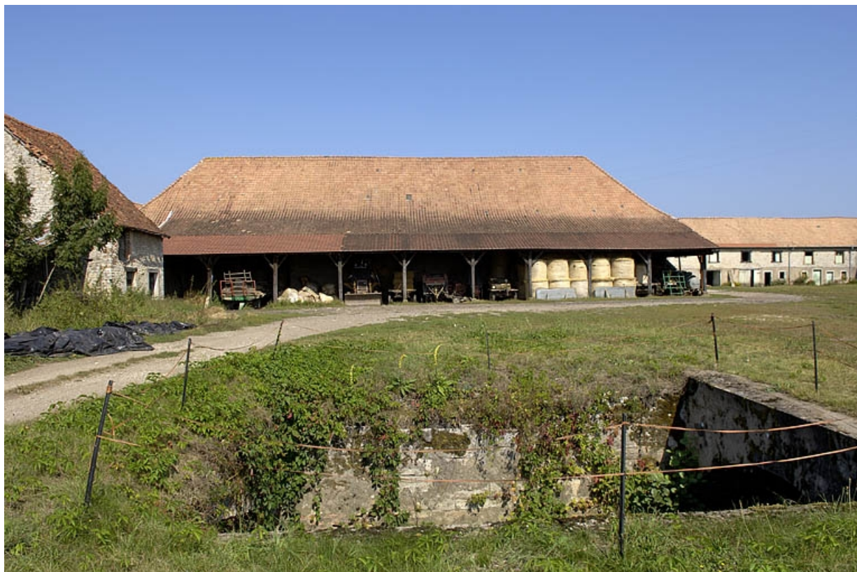
Halle à charbon vue depuis le sud.
