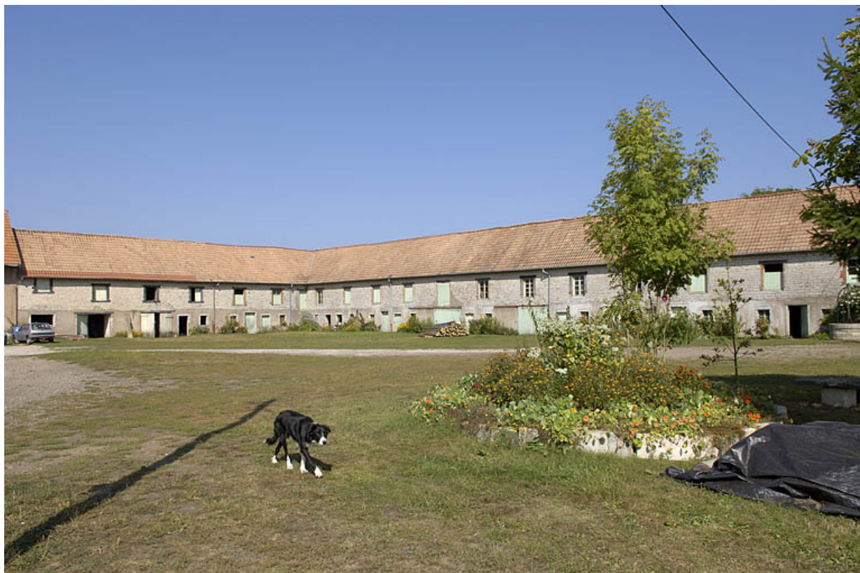
Logements ouvriers vus depuis le sud de la cour.
