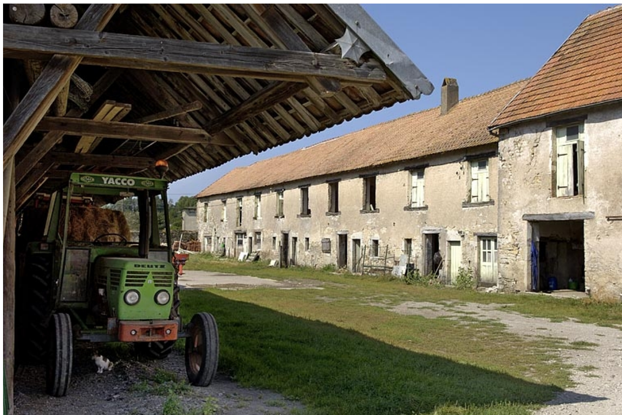
Aile ouest des logements ouvriers.
