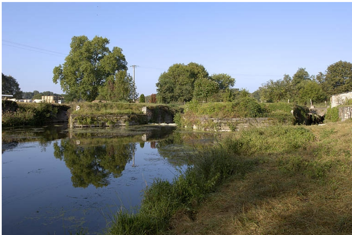
Massifs de maçonnerie, sur le bief d'amenée, où se trouvaient la forge et la fenderie. 70, Villersexel, lieudit : la Forge
