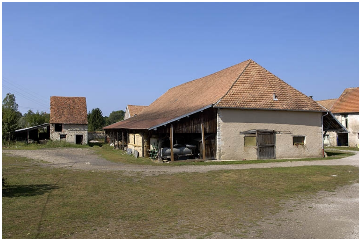
Vue depuis le sud-ouest de la cour.
