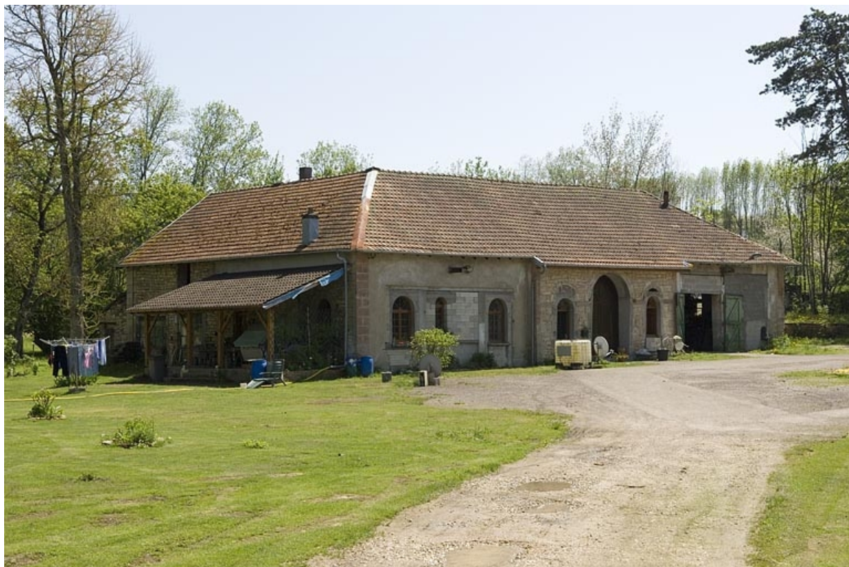
Bâtiment à usage multiple (logements, remises, écuries et ateliers divers).
