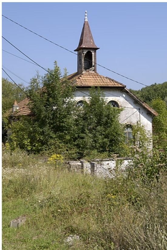
Salle des machines et atelier de réparation vus depuis le sud. 70, Fallon R.D. 90
