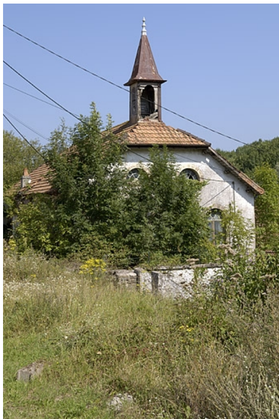
Salle des machines et atelier de réparation vus depuis le sud. 70, Fallon R.D. 90
