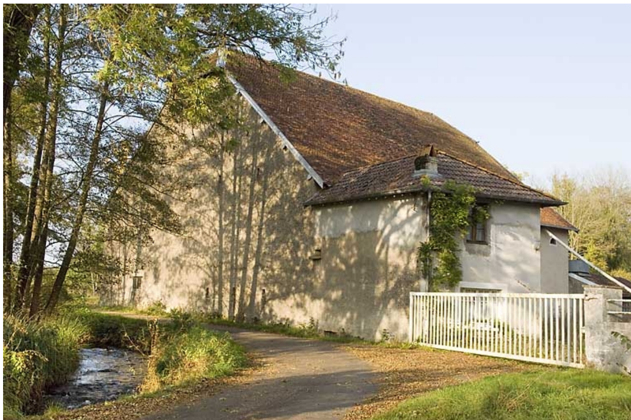
Bâtiment abritant les parties agricoles et les cellules à grain.
