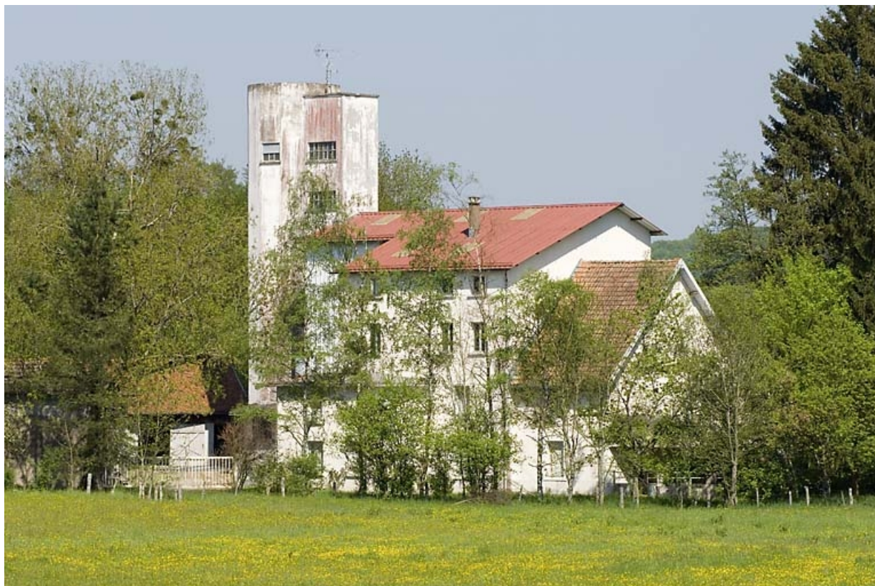
Façade occidentale vue de trois quarts.
