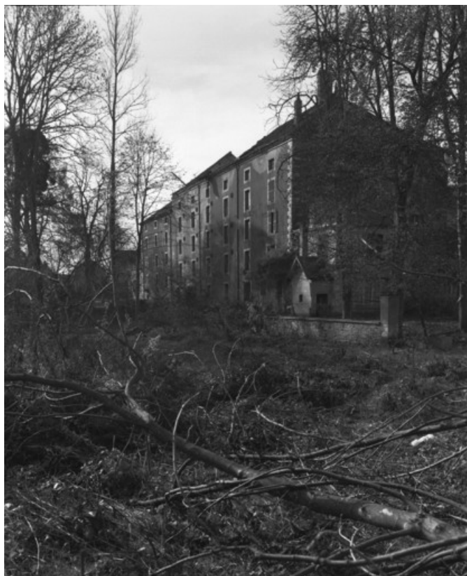
Façade postérieure du moulin public en 1989.
