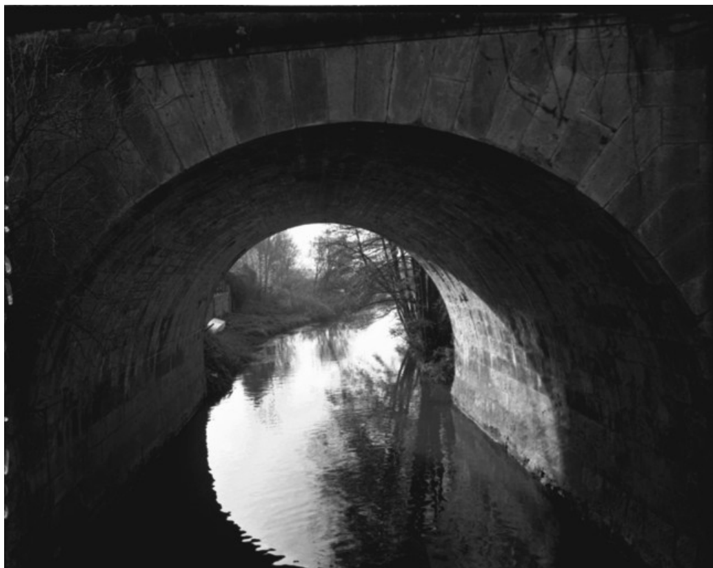
Passage voûté du canal de fuite sous la rue en 1989.
