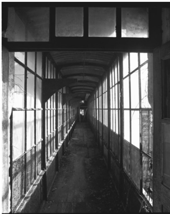
Intérieur de la passerelle en 1989.
