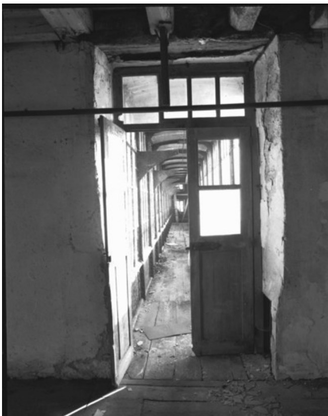
Accès à la passerelle depuis le moulin de commerce en 1989. 70, Port-sur-Saône rue Gilberte Lavaire
