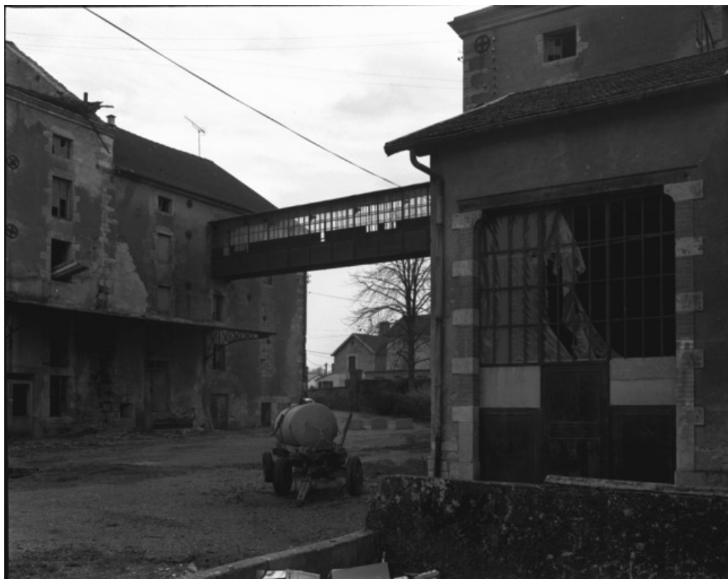
Extrémité sud du moulin public et passerelle en 1989.
