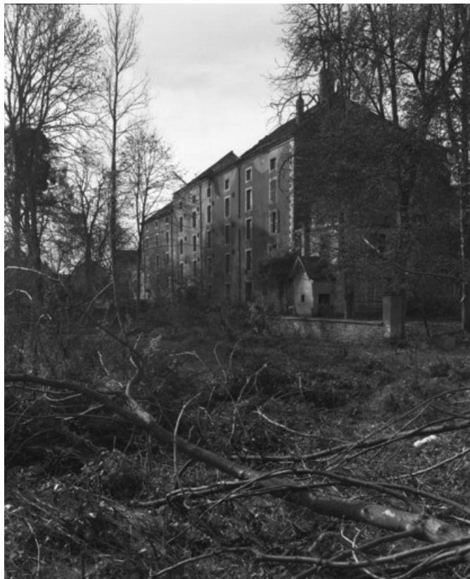
Façade postérieure du moulin public en 1989.
