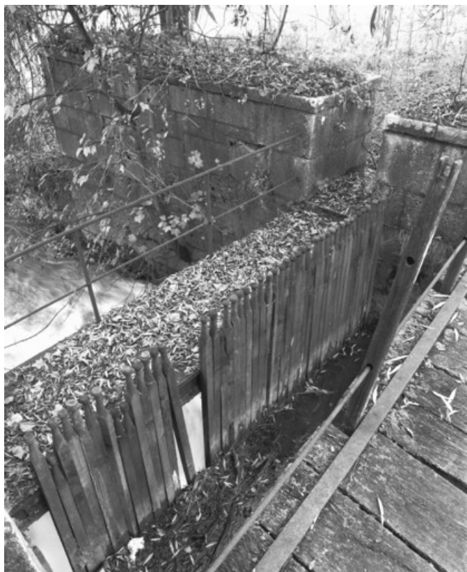
Barrage à aiguilles sur le canal d'amenée en 1989.
