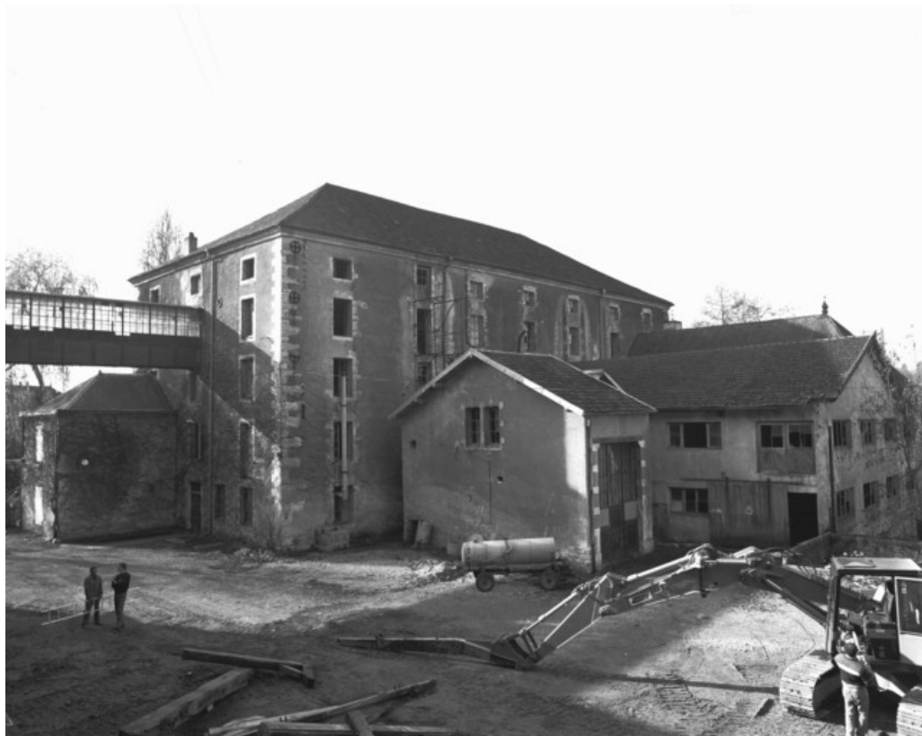
Le moulin de commerce vu de trois quarts arrière en 1989. 70, Port-sur-Saône rue Gilberte Lavaire
