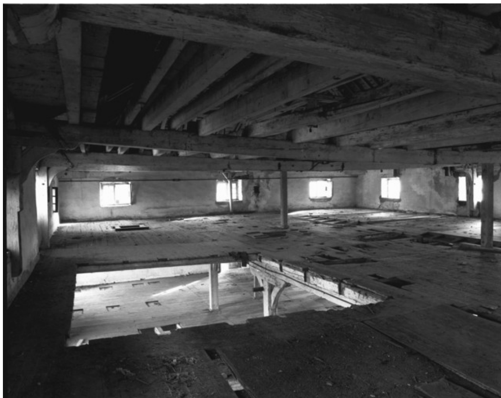
Intérieur du 5ème niveau du moulin de commerce en 1989.
