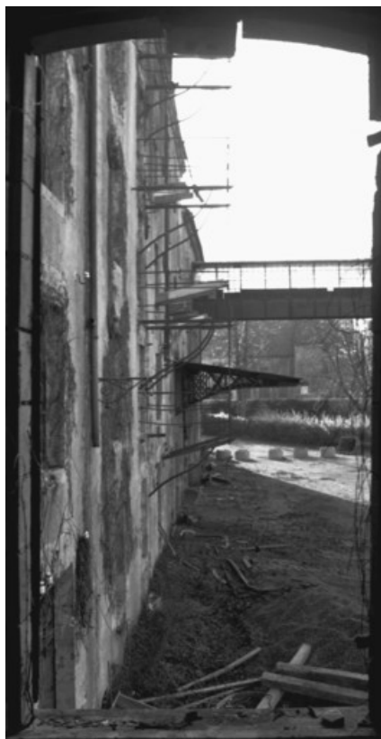
Élévation du moulin public depuis le logement en 1989.
