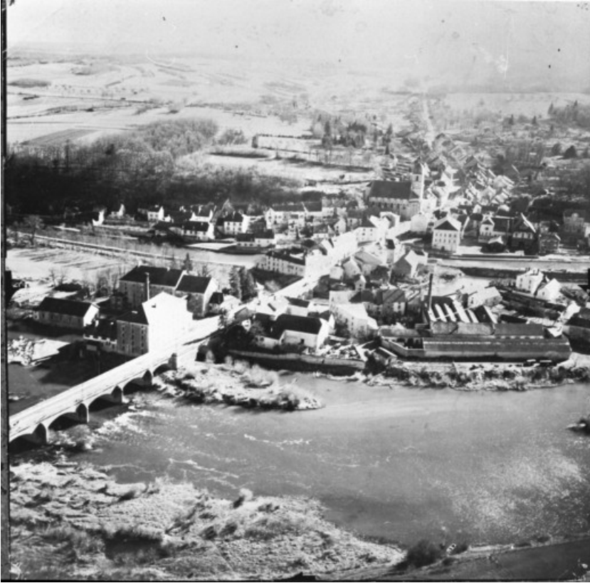
Vue aérienne depuis l'ouest.
