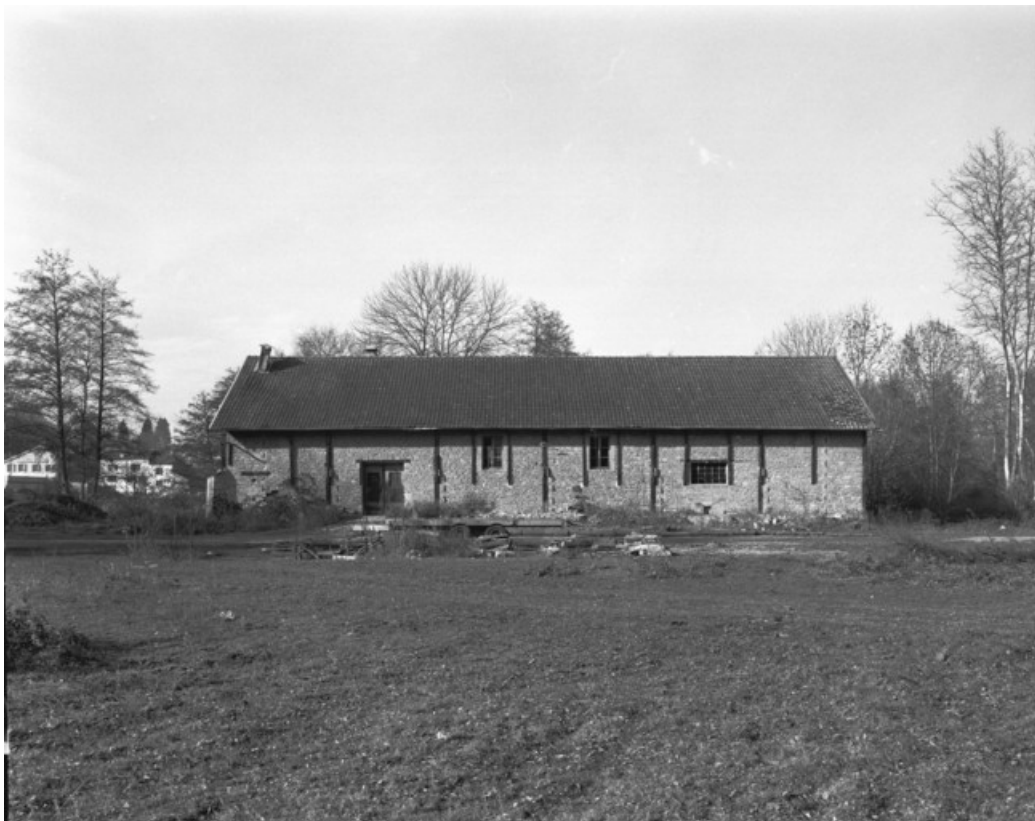
Vue de face de l'entrepôt industriel en 1989.
