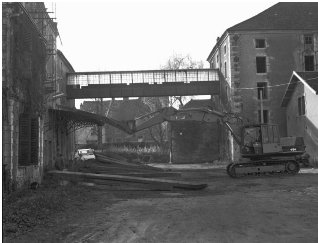
La passerelle depuis la cour en 1989. 70, Port-sur-Saône rue Gilberte Lavaire
