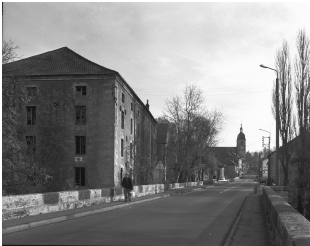
Vue générale de trois quarts gauche en 1989.
