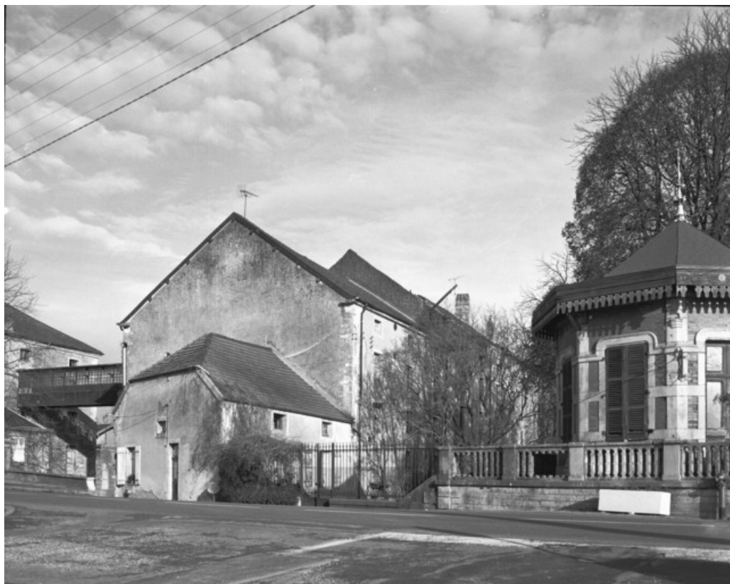
Vue générale de trois quarts droite en 1989.
