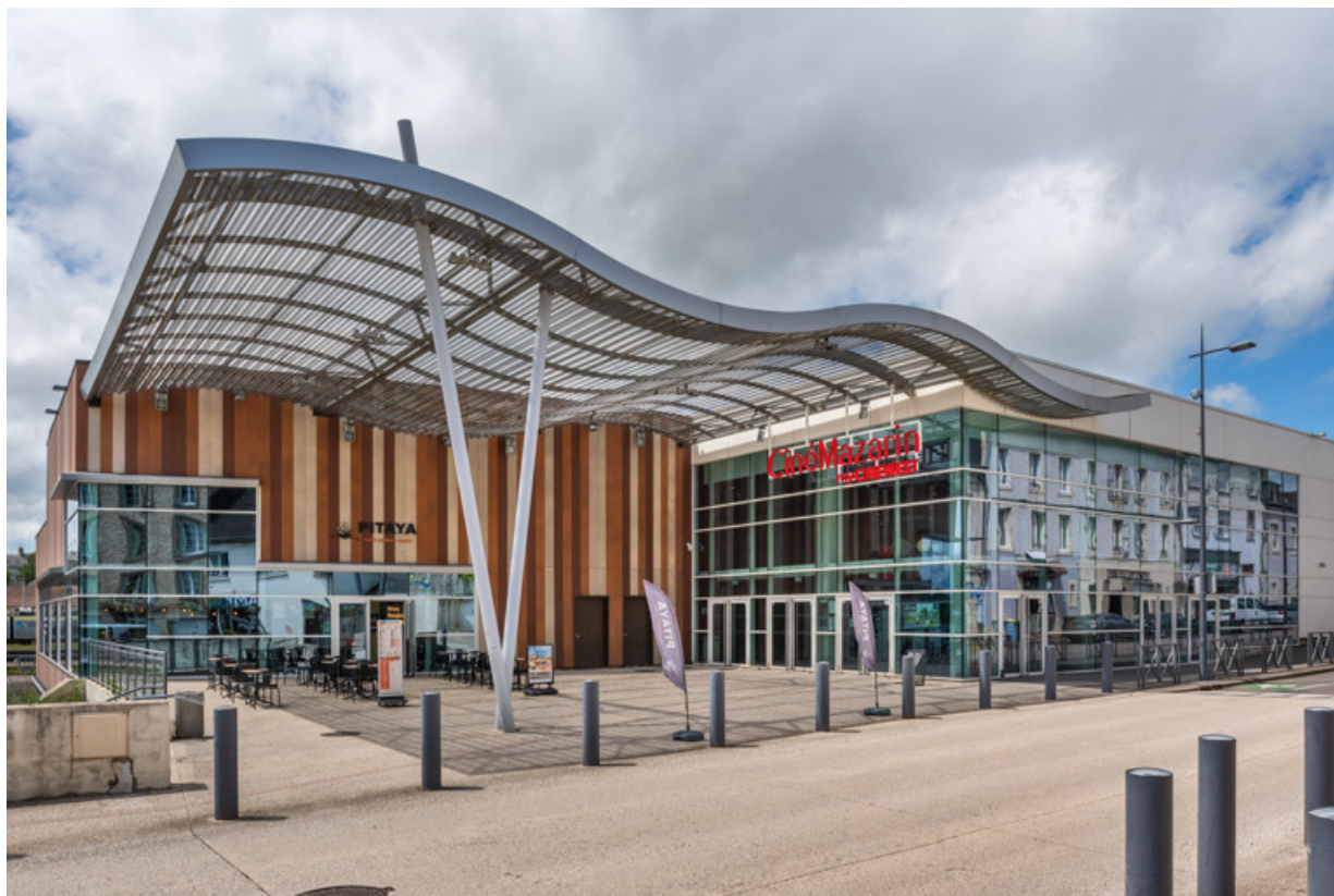
Nevers : multiplexe Ciné Mazarin (rue de Charleville).
