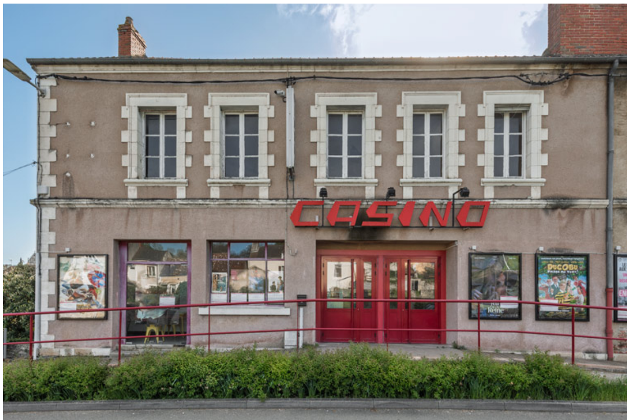
Clamecy : le Casino (41 route de Pressures).
