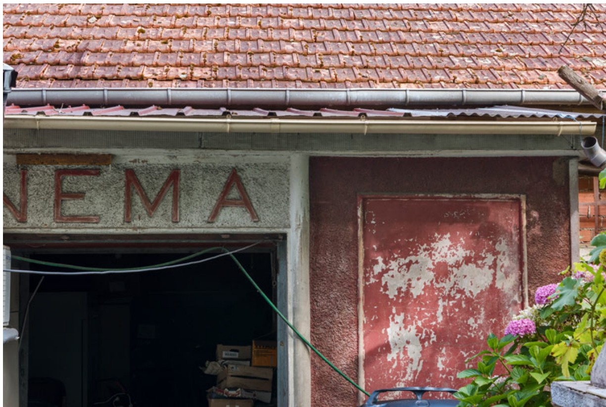
Prémery : café et cinéma Le Royal (19 rue des Ponts de Nevers). Détail de l'entrée : enseigne.
