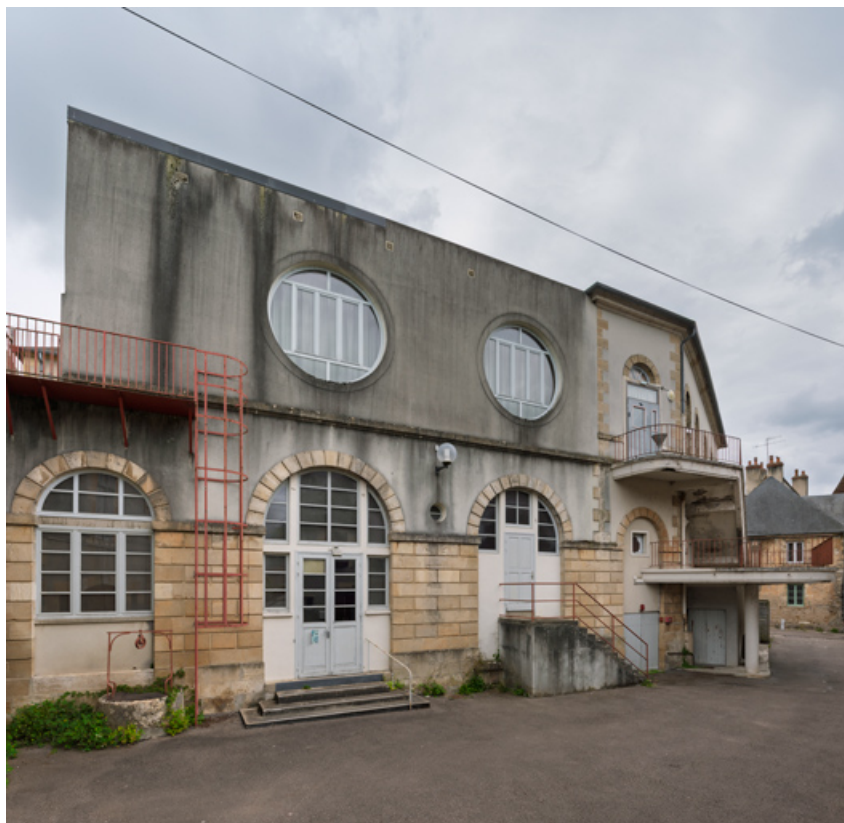
Façade latérale gauche de l'extension (salle de sport et salle des fêtes). 58, Prémery, 8 place de la Mairie
