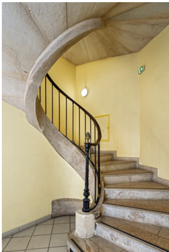
Rez-de-chaussée : escalier en vis.
