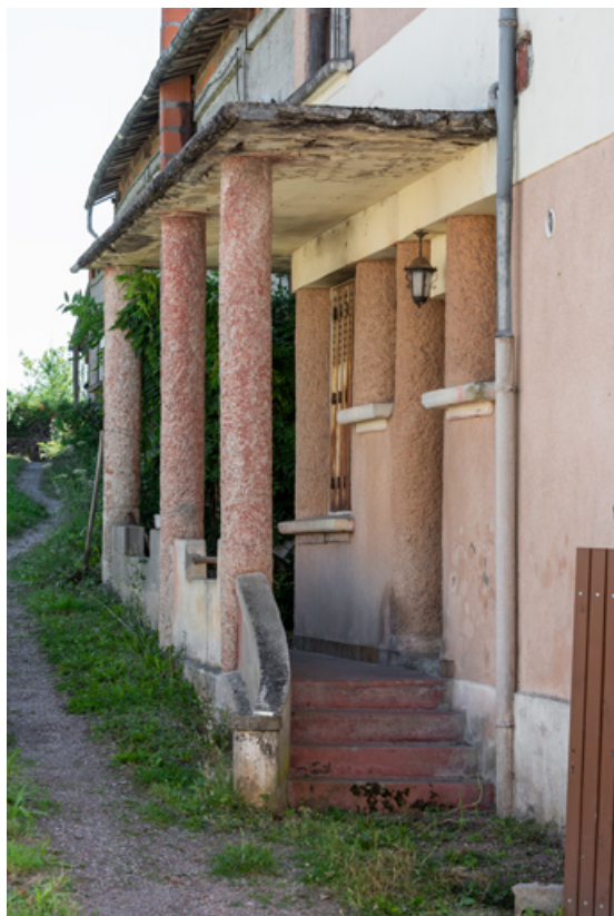
Façade latérale gauche : escalier couvert.
