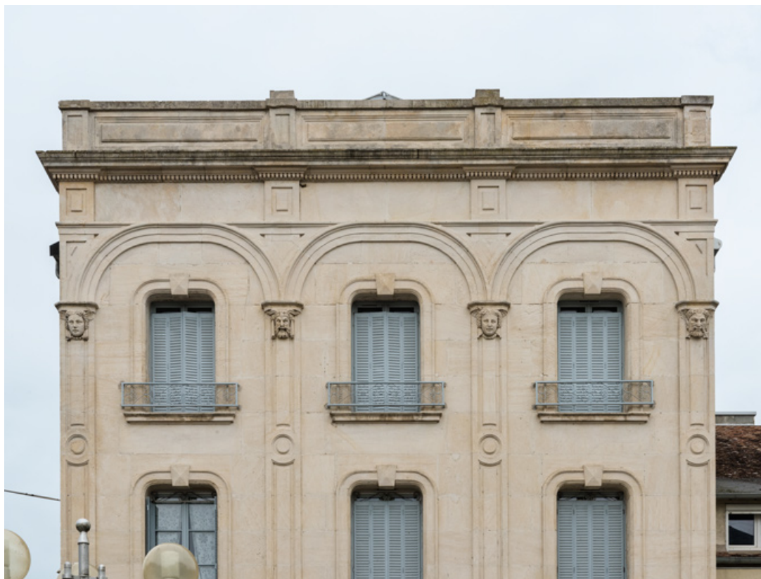
Façade antérieure : décor sculpté en partie haute.
