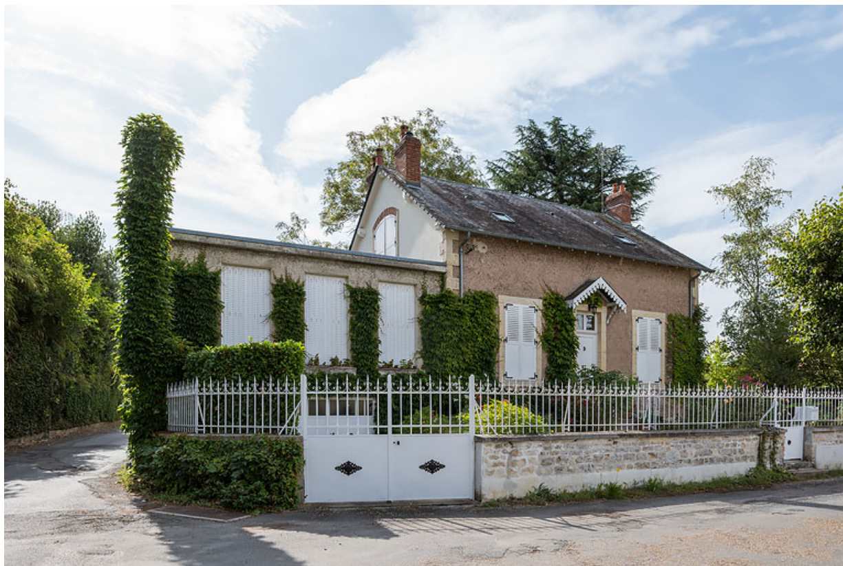
Vue de trois-quarts depuis le nord.
