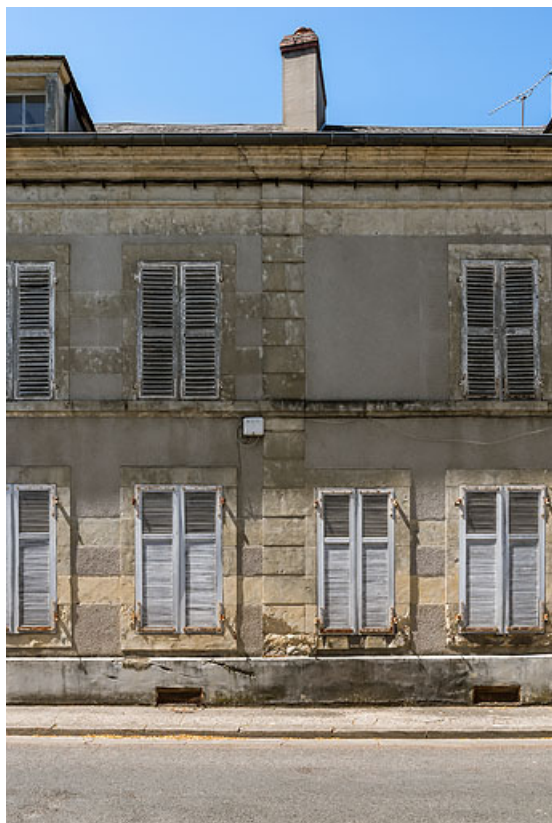
Façade sur la rue du Docteur Jean Pidoux, jambe marquant l'agrandissement de la demeure (à droite). 58, Pougues-les-Eaux, 57 avenue de Paris
