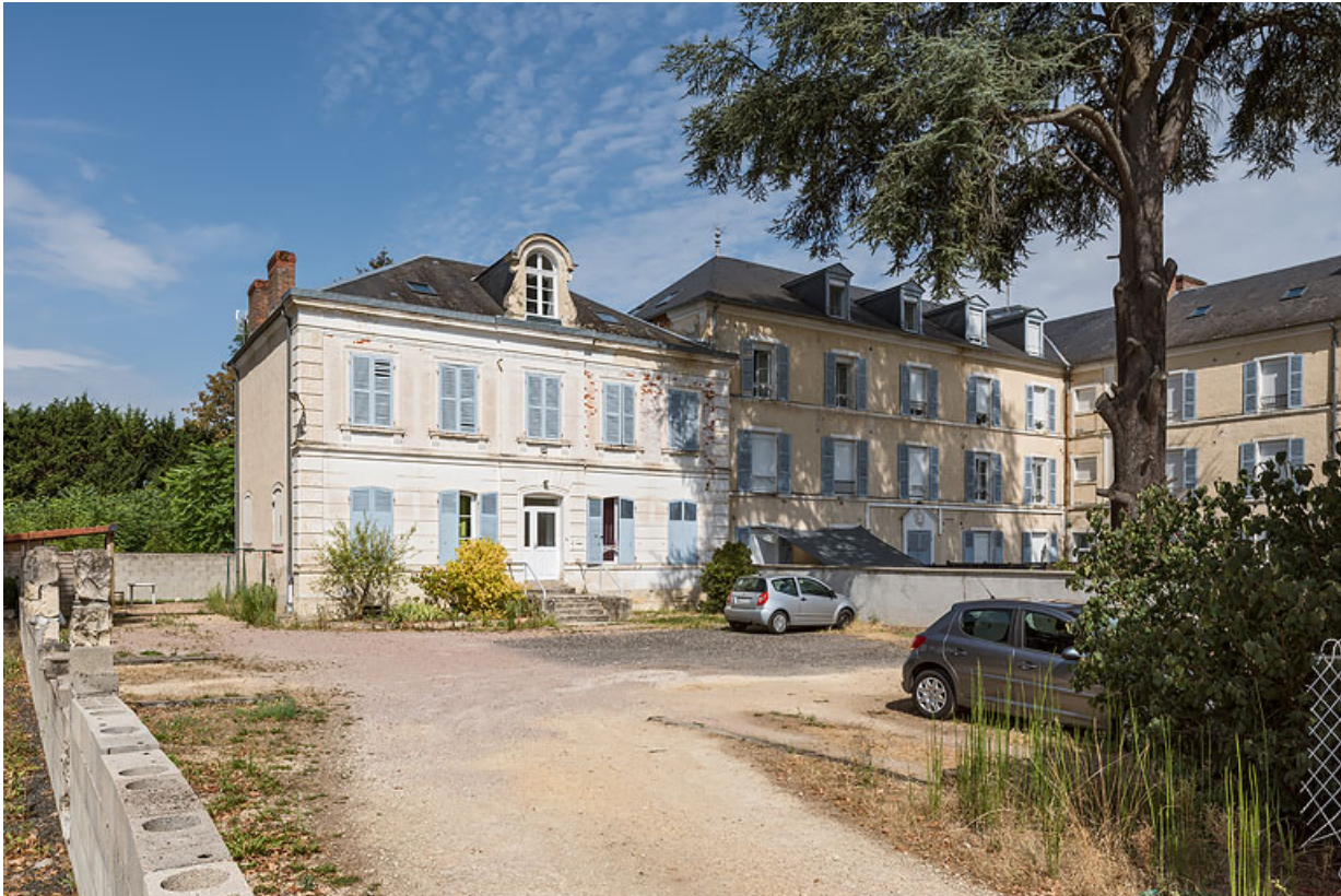
Façade principale de la villa, annexe de l'Hôtel du Parc (visible à droite). 58, Pougues-les-Eaux, 17 avenue de Conti
