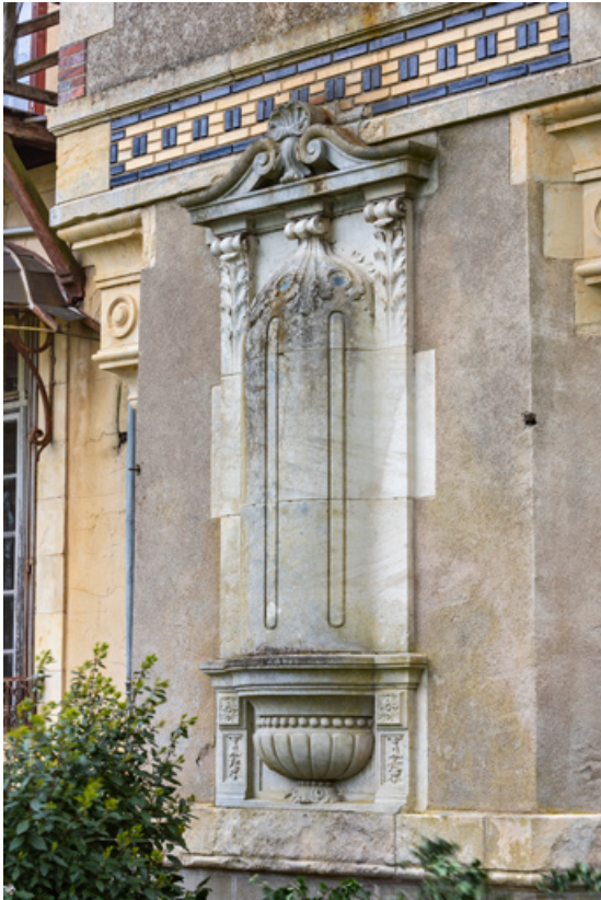
Tour à l'angle des façades ouest et sud, détail : ressaut correspondant à une niche intérieure remplaçant une baie. 58, Pougues-les-Eaux, 130 avenue de Paris, lieudit : La Montjaie
