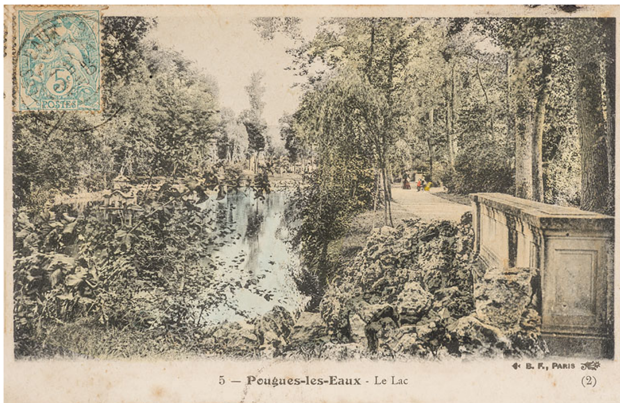
Pont de pierre au nord du lac (état au début du 20e siècle).
